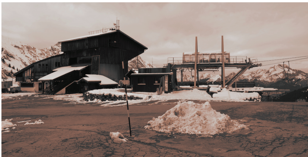
|104| Bâtiments désaffectés au niveau de la future porte d'entrée de la station
