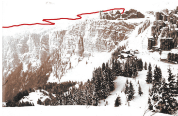
|102| La route, accès principal de la station par le haut
