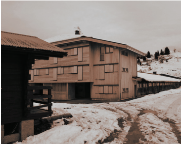
|112| Logements pour cochers au dessus des écuries
