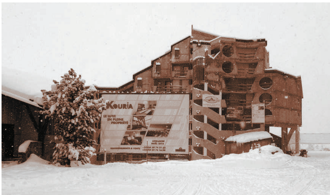
[44] Travaux de rénovation à l'arrêt durant l'hiver
