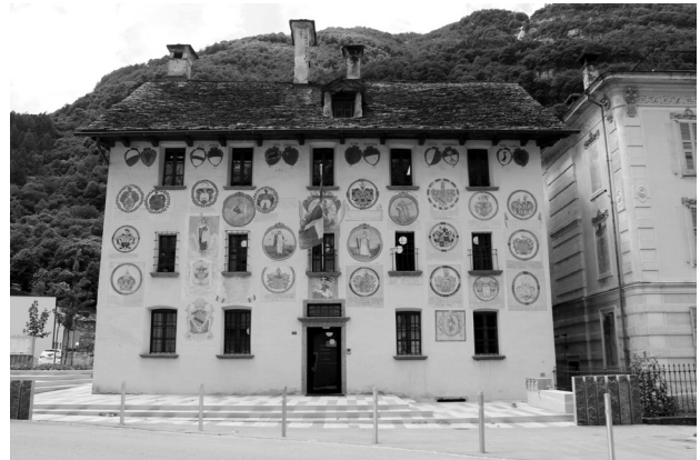
5 Casa del Landfogto
