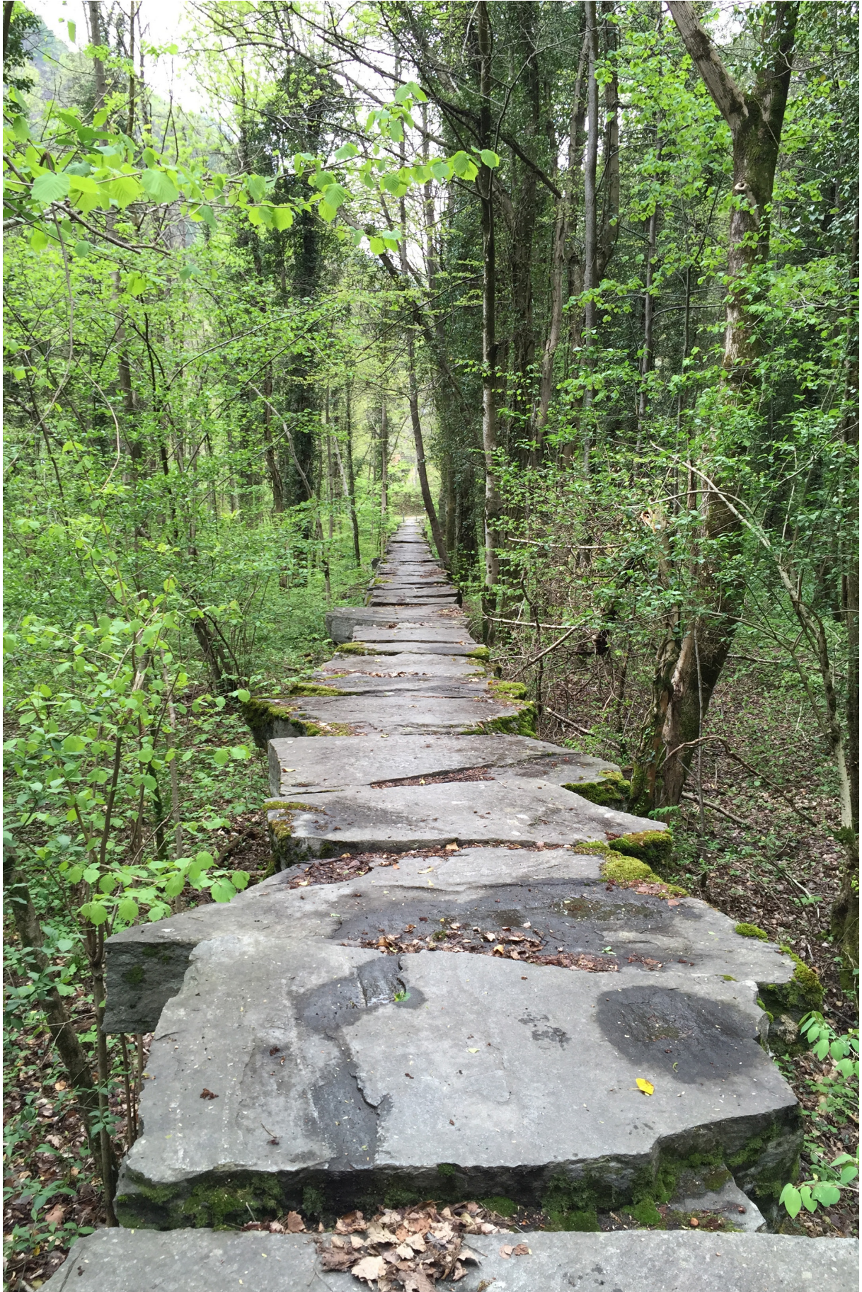
mur de protection contre la crue de la Maggia
