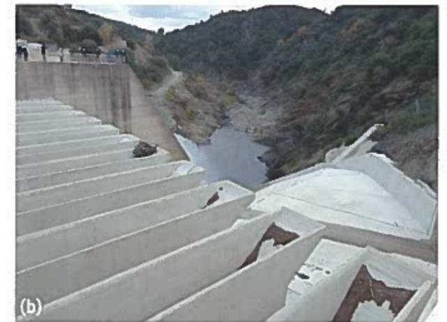
Abb. 3: Neu erstelltes PKW beim rechten Widerlager der Staumauer Malarce (F), Ansicht des (a) Ober- und (b) Unterwassers (Foto: Ende 2013).
