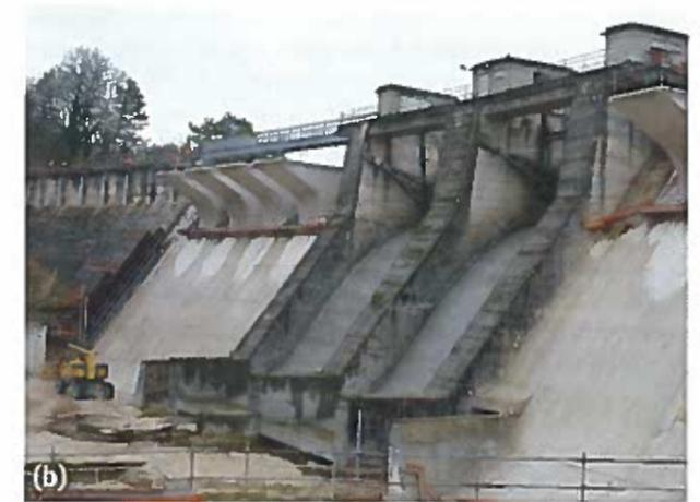
Abb. 2: Neu erstellte Zwillings-PKW auf der Staumauer Charmine (F), Ansicht des (a) Ober- und (b) Unterwassers (Foto: Ende 2014).
