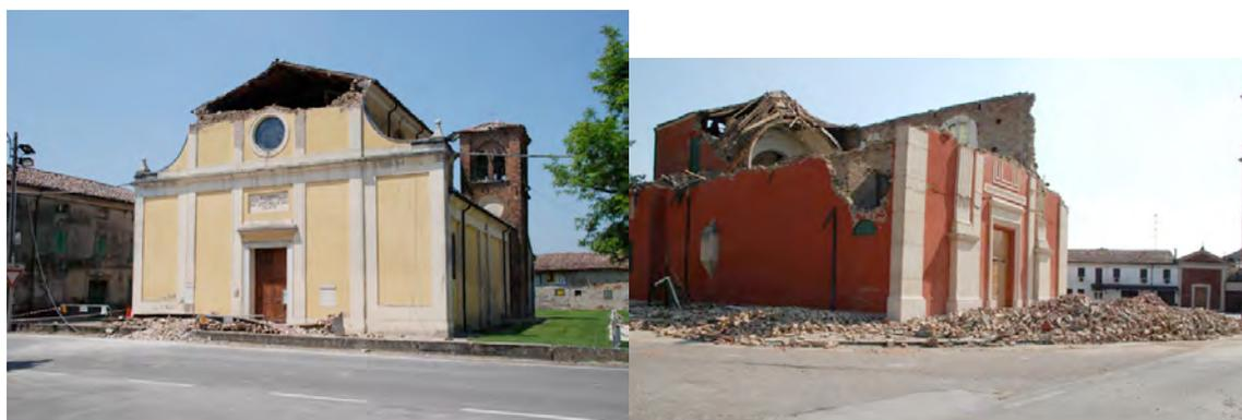
Figure 2 Rupture hors plan du fronton (à gauche) et effondrement (à droite) d'églises en maçonnerie lors du séisme d'Emilie-Romagne en 2012 [photos M. Baur et T. Wenk, mission de reconnaissance SGEB].
