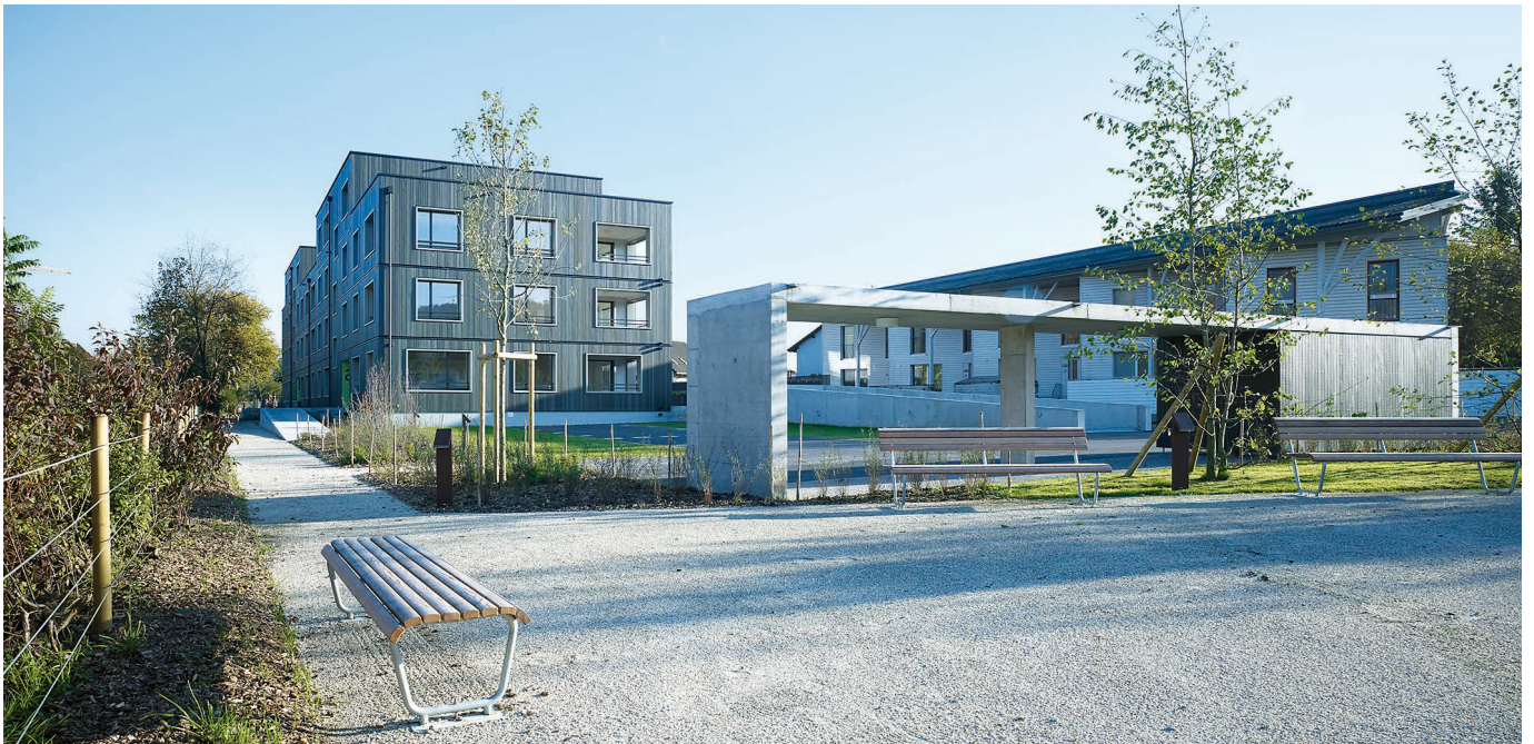
Bild 8. Wohnanlage Swisswoodhouse Nebikon
