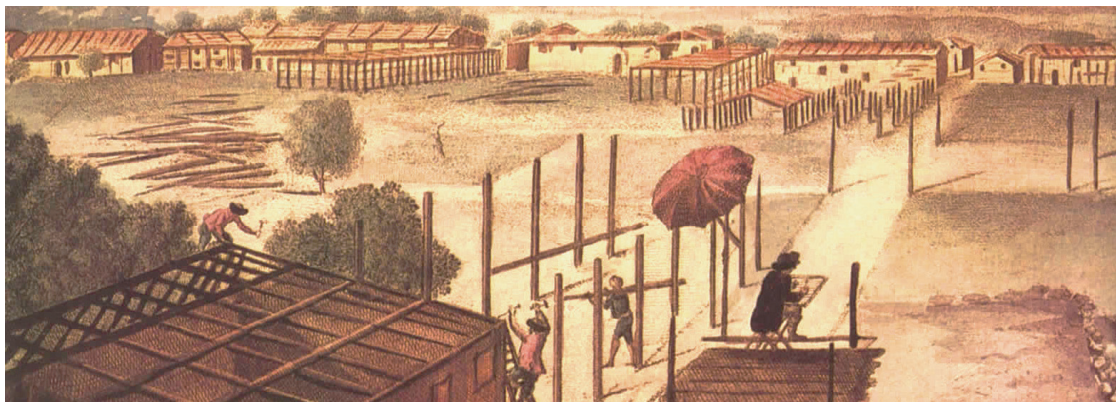
Fig.11 Peinture illustrant le déroulement des travaux de reconstruction de la ville de Polistena (Italie), suite au séisme de 1783, sous la supervision d'un responsable (Source : Placanica 1985).
