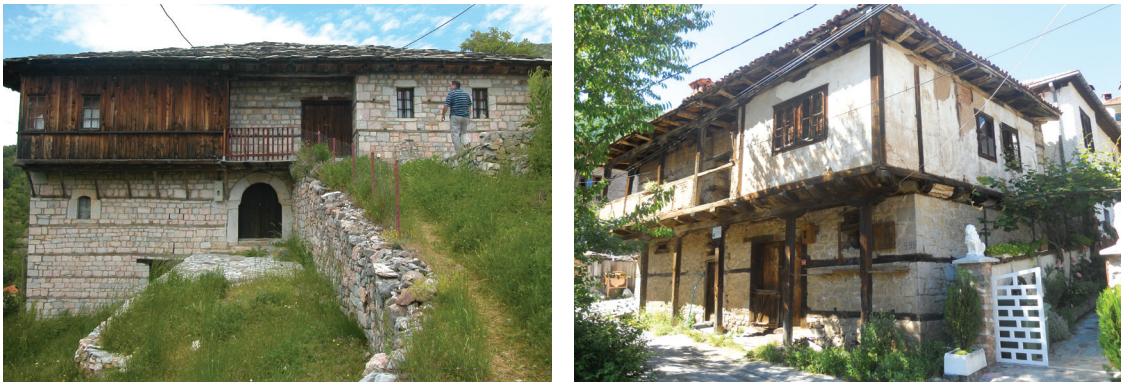
Fig.152 Ouvrages réalisés par des groupes de bâtisseurs connus pour leurs compétences et leur habileté constructive, ayant travaillé dans plusieurs régions des Balkans : a) Habitation datant d'environ 300 ans et récemment restaurée (Galitchnik) ; b) Habitation édifiée en 1890 (Vevçani).
