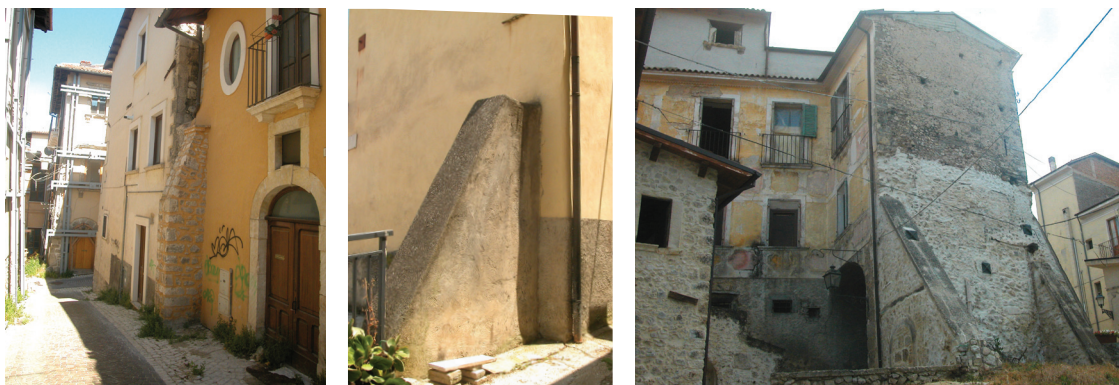
Fig.33 Contreforts ponctuels : a) Schéma ; b) L'Aquila ; c, d) Bugnara.
