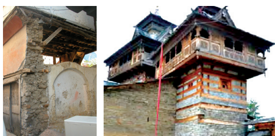
Fig.62 Pour plus de légèreté : a) Ossature sans remplissage recouverte avec du lattis enduit, Bartin, Turquie ; b) Réduction d'un tiers de l'épaisseur de la maçonnerie, Struga, Macédoine ; c) Accroissement de la fréquence des éléments horizontaux en bois, Pujarli, Etat de l'Himachal Pradesh, Inde (Crédit : Takkar et Dave).
