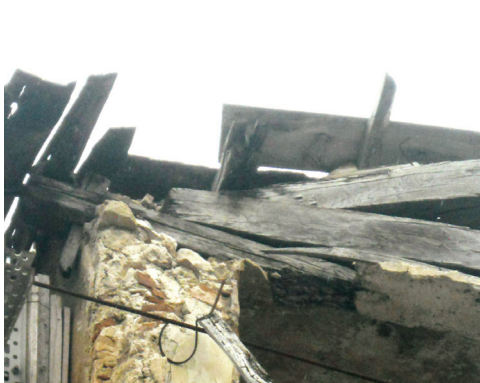
Fig.37 Ancrage entre les murs porteurs et la charpente du toit : a) Schéma ; b, c, d) L'Aquila.
