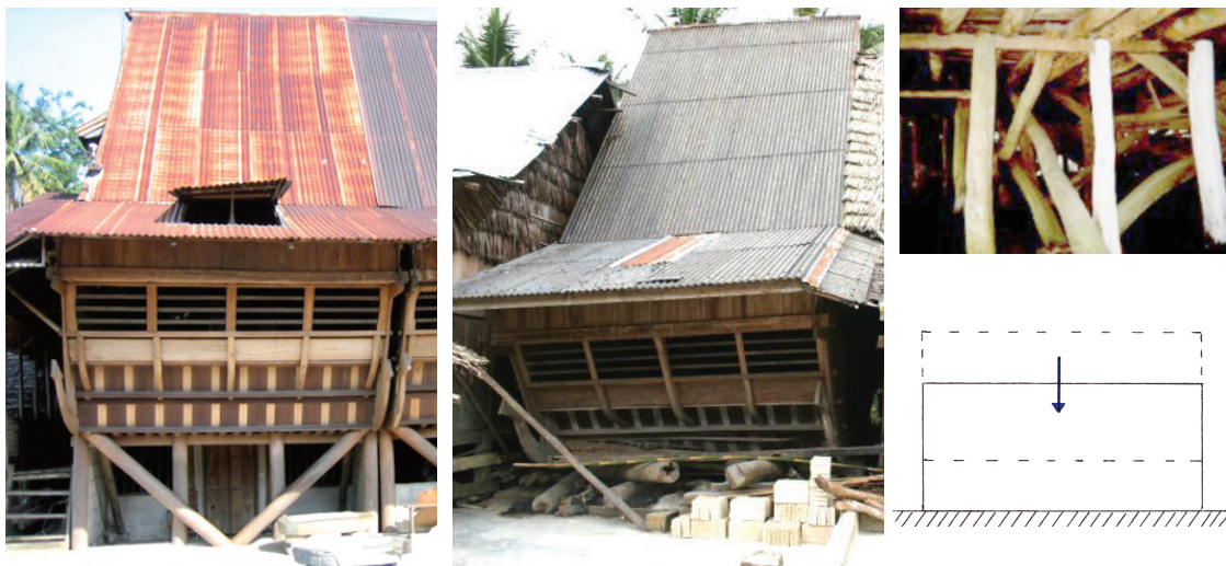
Fig.43 Rupture locale maîtrisée : Construction caractéristique de la région méridionale de île de Nias avant (a) et après (b) le séisme de 2005, Indonésie (Crédits : Wolff) ; c) Surélévation en bois dans un bâtiment de la région septentrionale de Nias (Crédit : Pudjisyuradi) ; d) Schéma : basculement de la partie supérieure.
