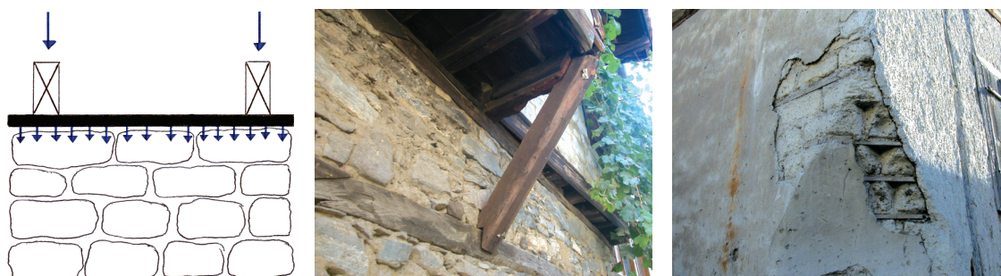
Fig.89 Autres fonctions assumées par les insertions horizontales : a) Schéma indiquant le rôle des insertions comme plaque de répartition des charges gravitationnelles transmises par les solives ; b) Appui pour les jambes de force (Ouest) ; c) Réalisation de parties du mur en porte-à-faux (Centre Ouest).
