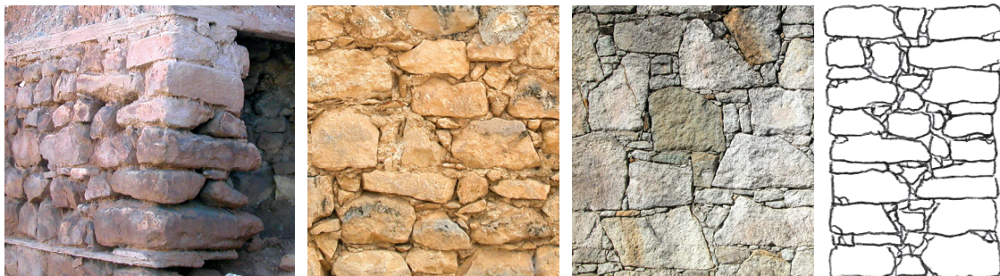
Fig.66 Rigidification de la maçonnerie : a) Pierres en boutisses traversantes, Kastamonu, Turquie ; b) Verrouillage des moellons avec des cailloux, Navelli, Italie ; c) Verrouillage des blocs avec des pierres taillées, Değirmendere, Turquie ; d) Schéma : coupe d'une maçonnerie en moellons avec verrouillage.
