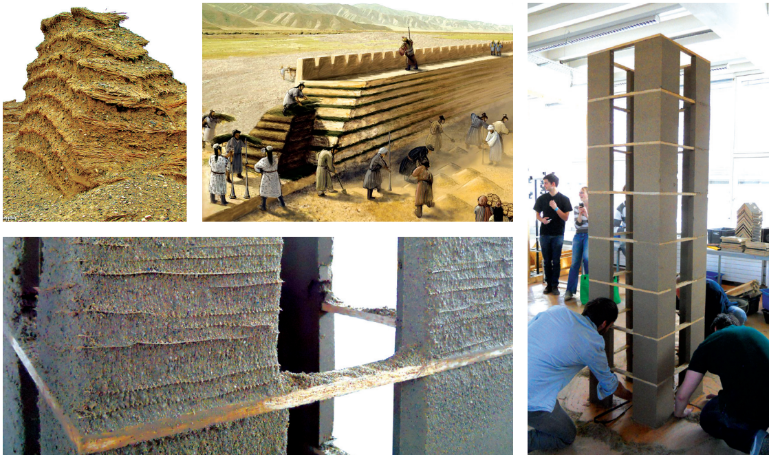
Fig.121 Sable armé : Muraille de Chine dans le désert de Gobi (a, Crédit : Thompson) et représentation de la mise en place de strates de branchages (b, Crédit : Chao) ; c,d) Tour de sable armé réalisée à l'EPFL dans le cadre du cours de l'Unité d'Enseignement ENAC Apprendre du vernaculaire la terre crue , en collaboration avec l'équipe d'AMàCO.
