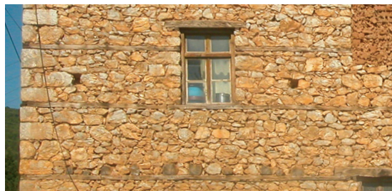
Fig.155 Détails de bâtiments réalisés par les bâtisseurs locaux : a) Chapiteau du poteau (Velmej) ; b) Intersection de murs perpendiculaires (Ohrid) ; c) Maçonnerie en moellons (Zlesti).
