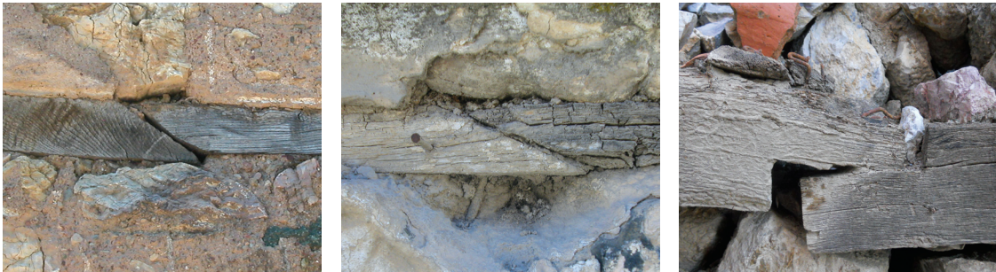
Fig.173 Raccordement entre les tasseaux longitudinaux : a) Liaison en biseau avec bois de bonne qualité (Vevçani) ; b) Assemblage en biseau avec bois pourri (Korçë) ; c) Joint à mi-bois avec clous rouillés (Ohrid).
