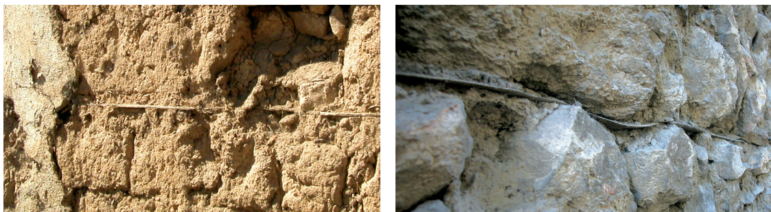
Fig.85 Feuillet en bois très minces : a) Dans la maçonnerie en briques de terre crue (Centre Ouest) ; b) Dans la maçonnerie en moellons (Centre Ouest).
