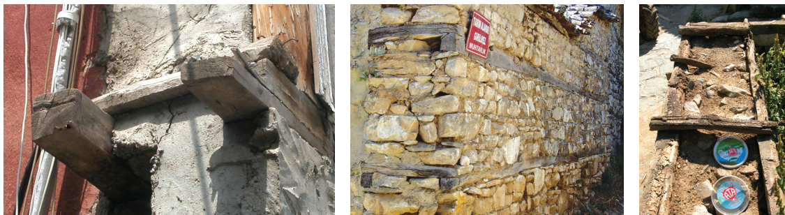
Fig.79 Tasseaux longitudinaux et traverses de connexion : a) Vue transversale (Est) ; b) Vue latérale (Ouest) ; c) Vue depuis le haut (Ouest).
