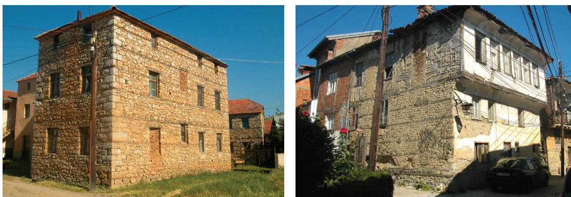
Fig.148 Architectures vernaculaires en maçonnerie de pierre ou en briques de terre crue avec insertions horizontales en bois en forme d'échelle : a) Habitation en zone rurale (Zlesti) ; b) Habitation en zone urbaine (Struga).
