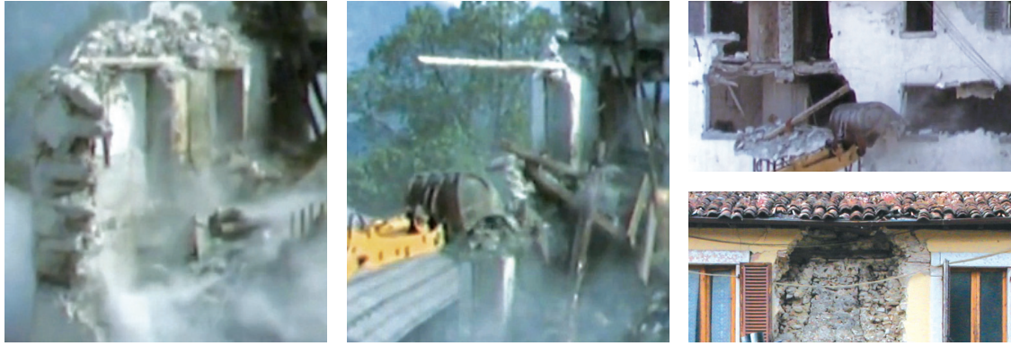
Fig.127 a,b,c) Photogrammes d'une vidéo documentant la démolition d'un bâtiment en maçonnerie de pierre à Vex (canton du Valais, Suisse) en 1981 (Crédits : Rudaz-Médiathèque Valais) : si l'existence de tirants reliant les murs entre eux au niveau du linteau pouvait être déduite par les ancrés métalliques visibles en façade, le fait qu'ils correspondent à des rondins en bois était difficilement décelable avant la destruction de l'édifice ; d) Rondin disposé au niveau du linteau dans un bâtiment de la ville de L'Aquila (Italie) ayant subi des dégâts relativement faible lors du séisme de 2009.
