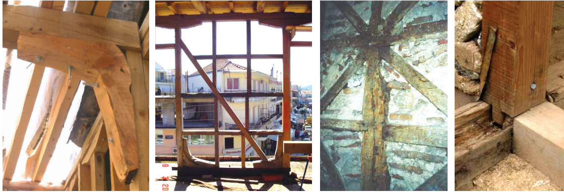
Fig.65 Liaisons entre éléments de l'ossature : Présence d'équerres en bois entre poteaux et poutres (a, Crédit : Makarios et Demosthenous) et de chapiteaux entre montants et soles hautes (b, Crédit : Karababa et Guthrie), Leucade, Grèce ; c) Assemblages à encoche, Lisbonne, Portugal (Crédit : Cardoso) ; d) Joint à tenon et mortaise avec feuillet métallique entre montant et sole basse, Pakistan (Crédit : Schacher).
