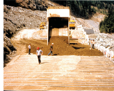
Fig.119 Mur de soutènement routier en terre armée : la terre est compactée entre le talus et un parement constitué d'écailles en béton fixées aux armatures (Crédit : Recocanada dans Anger 2011).
