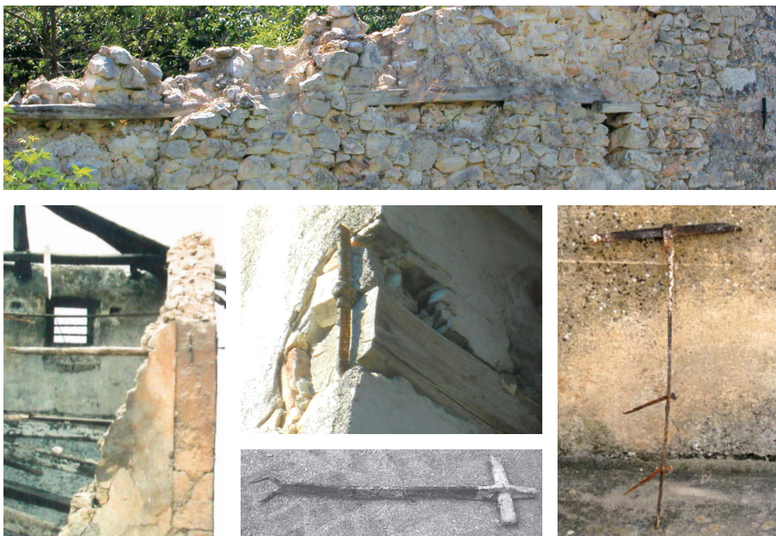
Fig.31 Tirants en bois : a) Rondin noyé dans la masse du mur, Poggio Picenze ; b) Tirant visible suite au démantèlement de la maçonnerie, L'Aquila (Source : Hotel99cannelle) ; c) Ancre de façade de taille réduite, L'Aquila ; Pièces métalliques de connexion avec crochet d'ancrage (d, Crédit : D'Antonio) ou avec deux grands clous (e, Crédit : Lagomarsino).
