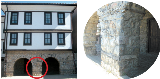
Fig.114 a) Bâtiment avec des insertions horizontales en bois dans les piliers en maçonnerie composant le système porteur vertical du rez-de-chaussée, Ohrid, Macédoine ; b) Vue rapprochée.
