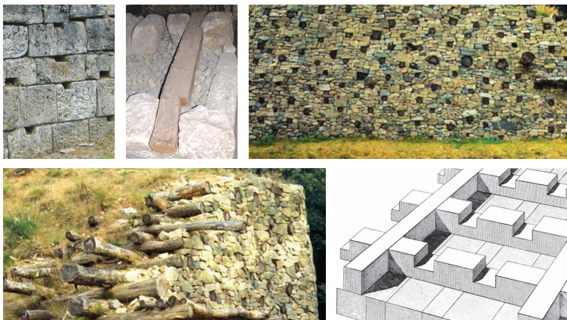
Fig.123 Murus Dacicus : Maçonnerie de pierre avec trous pour les traverses à Blidaru en Roumanie (a, Crédit : Oroles) et modèle reconstruit montrant la liaison particulière entre les parements et la traverse, assurant leur bon ancrage (b, Crédit : Codrin) ; Murus Gallicus : Façade (c) et section (d) d'un mur reconstruit dans l'ancienne ville de Bibracte, France (Crédits : Gavet) ; e) Dessin des assemblages mi-bois d'après Rondelet (Source : http://echo.mpiwg-berlin.mpg.de/home ).
