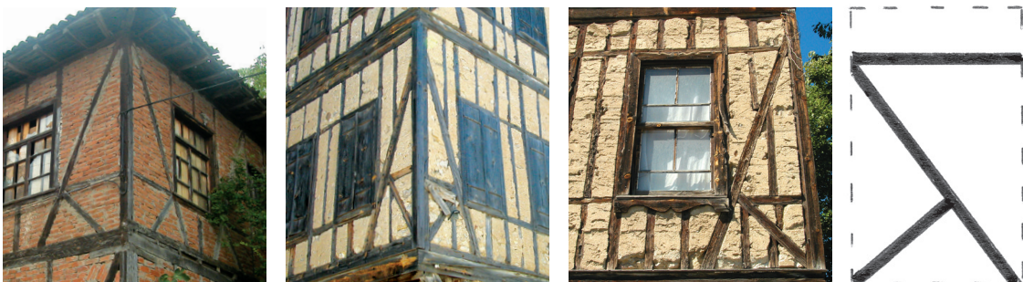
Fig.100 Contreventement en forme de « Y renversé » : a) Avec diagonale liée à la sole haute (Centre Est) ; b) Avec diagonale s'appuyant au montant (Centre Ouest) ; c) Avec traverse stabilisant la diagonale (Centre Ouest) ; d) Schéma de la variante avec traverse.
