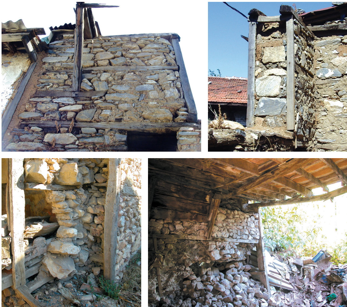
Fig.109 Spécificités propres aux maçonneries avec éléments horizontaux et verticaux en bois (Ouest) : a,b) Module très régulier ; c) Pierres maintenues en place par la structure en bois ; d) Plancher soutenu par les montants, en cas de défaillances dans la maçonnerie.
