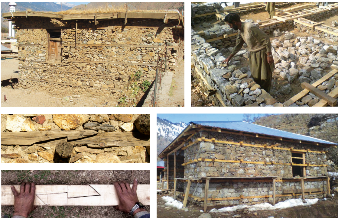
Fig.139 a) Bâtiment ayant résisté au tremblement de terre de 2005 (Crédit : Schacher) ; Chantier-formation mis en place pendant le programme de reconstruction (b) et ouvrage réalisé par les maçons formés (c, Crédits : Schacher) ; Détail de l'assemblage à trait de jupiter, très résistant à la traction, dans une construction ancienne (d, Crédit : Schacher) et sa réinterprétation contemporaine (e, Crédit : Stephenson).
