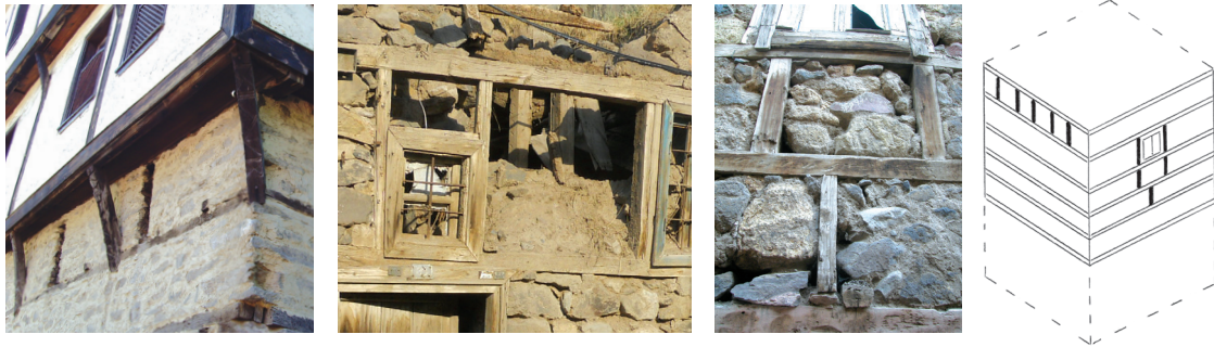
Fig.81 Eléments verticaux en bois : a) Entre les tasseaux longitudinaux (Ouest) ; b) À côté des ouvertures (Est) ; c) Au-dessous des fenêtres (Est) ; d) Schéma : axonométrie indiquant leur emplacement dans les bâtiments.
