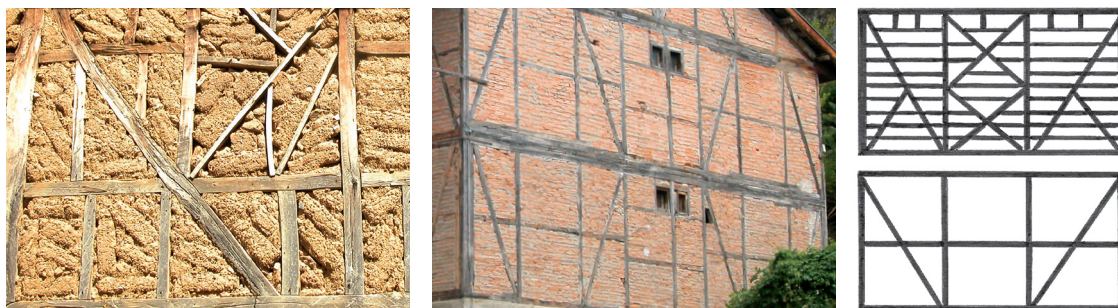
Fig.94 Rapport bois/remplissage ; a) Environ 1 sur 5 (Ouest) ; b) Environ 1 sur 20 (Centre Est) ; c) Schémas : densité du bois dans les deux variantes.
