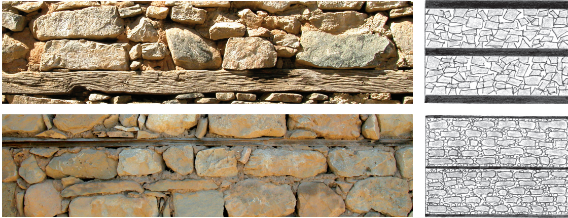
Fig.86 Appareillage de la maçonnerie en moellons : a) Nombreux espaces entre les unités maçonnées, en présence d'insertions en forme d'échelle (Ouest) ; b) Schéma de cette variante du mur en élévation; c) Verouillage des moellons avec des cailloux dans les murs comprenant des planches minces (Centre Ouest) ; d) Schéma de cette variante du mur en élévation.
