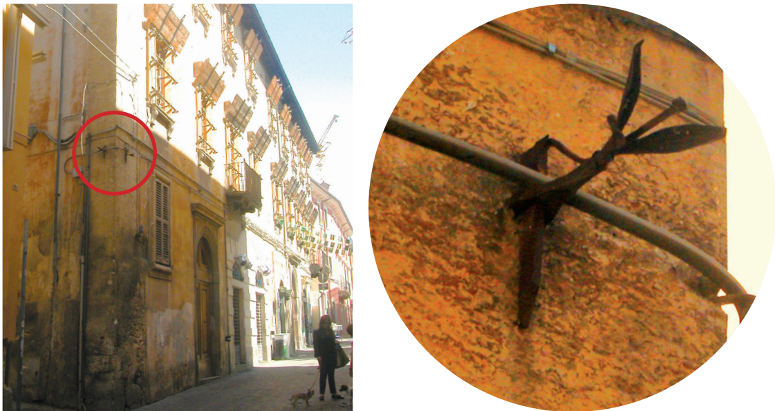
Fig.28 Fleurs de lys fixées aux tirants : a) Bâtiment de quatre niveaux dans le centre historique de L'Aquila, b) Vue rapprochée.
