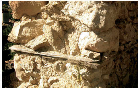
Fig.64 Arases dans le mur : a) Assise en briques de terre cuite traversant la section de la maçonnerie de pierre, Ohrid, Macédoine ; b) Planche en bois occupant toute l'épaisseur du mur, Safranbolu, Turquie ; c) Schéma : répartition de la pression verticale.
