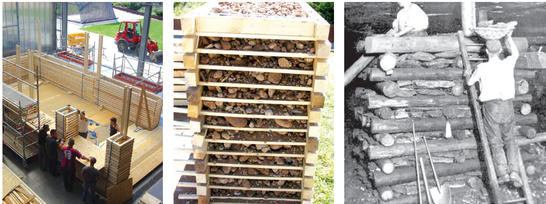
Fig.122 Terre confinée : Chantier du prototype de l'hébergement d'urgence réalisé à Grenoble (a) et détail du système porteur vertical (b, Crédits : Porte dans Anger 2011) ; c) Pilier de soutènement dans une mine de charbon, Yorkshire, Angleterre (Source : www.miningartifacts.org).
