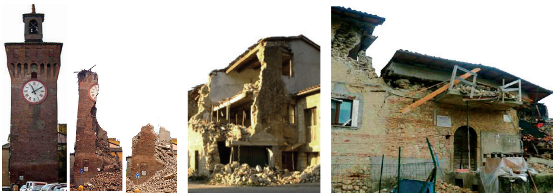
Fig.17 Bâti ancien et tremblements de terre, Italie : a) Ecoulement de la Tour de l'Horloge de Finale Emilia datant du XIII e siècle, provoqué par la séquence sismique ayant affecté la région de l'Emilie-Romagne en 2012 (Crédits : Carozzino) ; Conséquences néfastes d'interventions récentes : b) Création d'une grande ouverture à l'angle de l'immeuble au rez-de-chaussée pour la réalisation d'un garage, Verchiano après le séisme des Ombres de 1997 (Source : Ferrigni et al. 2005) ; c) Réalisation d'un chaînage en béton armée au niveau du toit visant l'amélioration de la résistance sismique du bâtiment en maçonnerie, Tempéra après le séisme de L'Aquila de 2009 (Source: Bazzurro et al. 2009).
