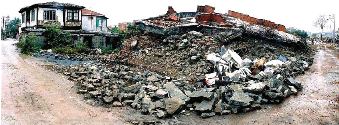
Fig.14 Turquie, après le séisme de Kocaeli de 1999 : effondrement d'un bâtiment récent et résilience d'une construction vernaculaire dans la ville d'Adapazari (Crédit : Langenbach).
