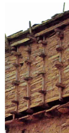
Fig.67 Stabilisation d'éléments horizontaux en bois de faible épaisseur avec des aiguilles verticales, vallée de Parun, Afghanistan (Crédit : Edelberg).
