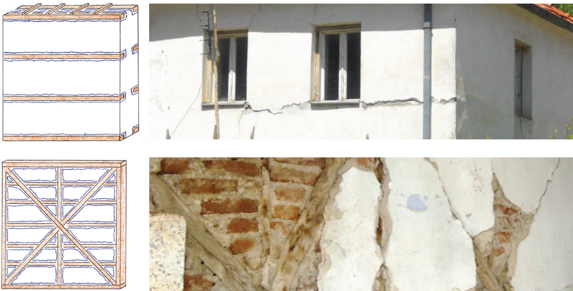
Fig.69 a) Schéma des zones de frottement externe entre la maçonnerie et les insertions horizontales en bois ; b) Bâtiment après un séisme, Velmey, Macédoine ; c) Schéma des zones de frottement externe entre l'ossature bois et le remplissage ; d) Bâtiment après un séisme, Değirmendere, Turquie.
