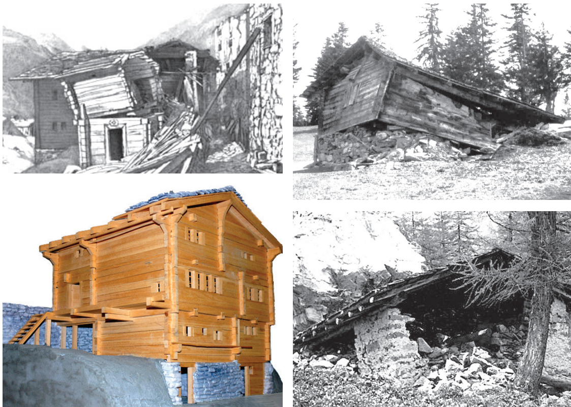
Fig.7 Architectures vernaculaires dans le canton du Valais : a) Lithographie illustrant les dégâts provoqués par le séisme de Viège de 1855, St. Niklaus (Crédit : Heusser 1856 dans Fritsche et al. 2006) ; b) Maquette d'un bâtiment d'habitation en madriers de bois, Weissenried (Crédit : EPFL) ; Effets du séisme de Sierre de 1946 sur des cabanes d'alpage en madriers (c, Crédit : Keystone) et en maçonnerie de pierre (d, Crédit : Schmid-Médiathèque Valais).
