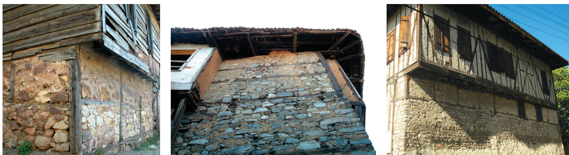
Fig.110 Utilisation ponctuelle du procédé constructif au sein des bâtiments : a) Au rez-de-chaussée (Ouest) ; b) Pour les niveaux supérieurs, en alternance avec des parois à ossature bois (Ouest) ; c) En correspondance de la liaison verticale entre des murs en maçonnerie et l'ossature des étages (Centre Ouest).
