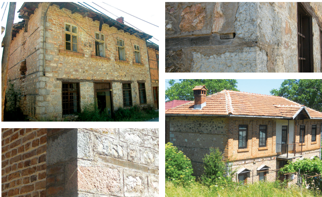
Fig.156 Façades sans insertions horizontales apparentes (Vevçani) : a,b) Insertions vraisemblablement dissimulées à l'intérieur du mur ; c,d) Insertions vraisemblablement mises en place uniquement dans les murs latéraux.
