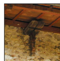
Ancrage entre mur et charpente du toit
