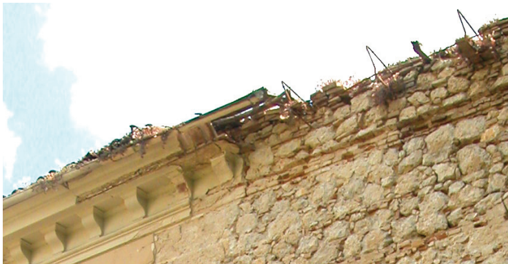
Fig.36 Corniches « vides » : a) Schéma ; b, c) L'Aquila.
