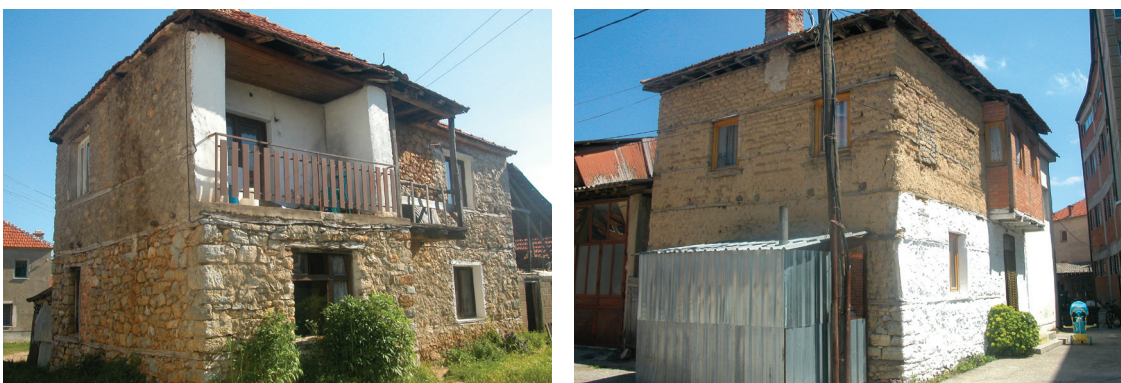
Fig.153 Ouvrages réalisés par des groupes de bâtisseurs travaillant à l'échelle locale : a) Habitation en moellons datant de 1965 (Zlesti) ; b) Habitation en briques de terre crue édifiée dans la deuxième moitié du XX e siècle (Struga).
