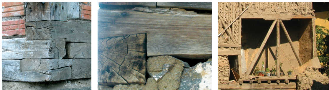
Fig.103 Assemblages spéciaux : a,b) Joint à queue d'aronde (Centre Est, Est) ; c) Long chapiteau (Centre Est).
