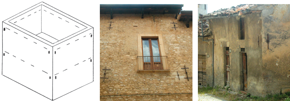
Fig.29 Tirants métalliques : a) Schéma de leur emplacement ordinaire aux niveaux des planchers et de la toiture ; b) Sulmona ; c) Camarda.
