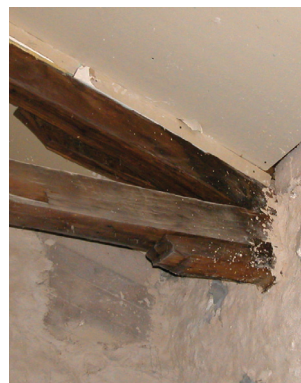
Fig.37 Ancrage entre les murs porteurs et la charpente du toit : a) Schéma ; b, c, d) L'Aquila.
