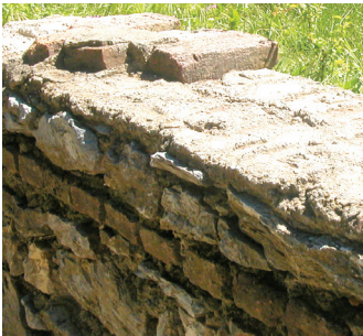
Fig.64 Arases dans le mur : a) Assise en briques de terre cuite traversant la section de la maçonnerie de pierre, Ohrid, Macédoine ; b) Planche en bois occupant toute l'épaisseur du mur, Safranbolu, Turquie ; c) Schéma : répartition de la pression verticale.
