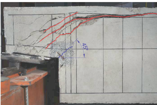
Figura 2. Mapa de fisuración en rotura. DEB-1.8 [6]
