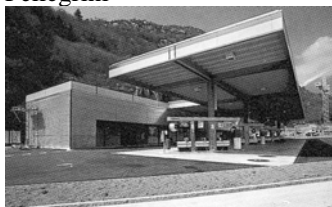
Stazioni de servizio Shell a Bellinzona nord e sud Bellinzona (TI), 1984-85 con Aurelio Galfetti e Claudio Pellegrini
