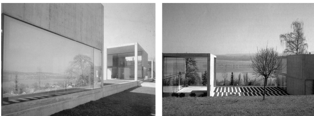
116. Silvia Gmür e Livio Vacchini. La casa delle tre donne. Beinwil am See, 1995-1998.
