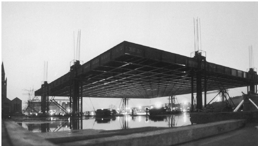
124. Ludwig Mies van der Rohe. Neue Nationalgalerie. Berlino, 1962-1968. Vista del cantiere.
