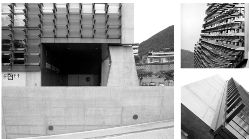
86. Livio Vacchini. Centro dei servizi. Locarno, 1989-1997. Particolare appoggio.
