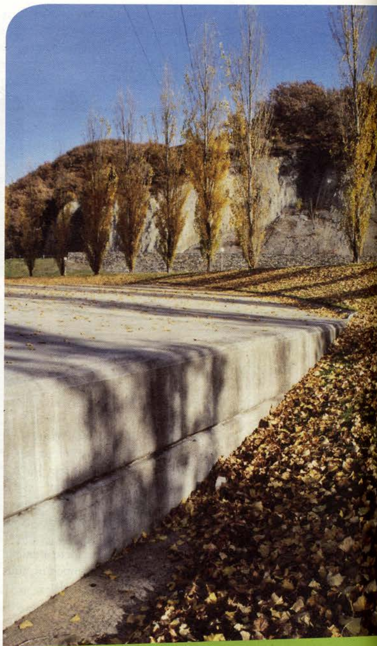
L'autoroute entre dans le talus du parc de Gèronde.
