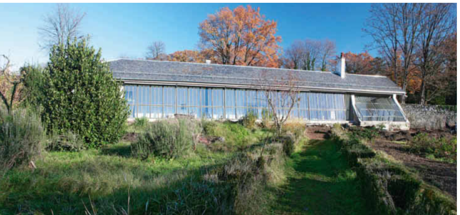
Schwingende Spiegelungen der Glasfassade der Orangerie
