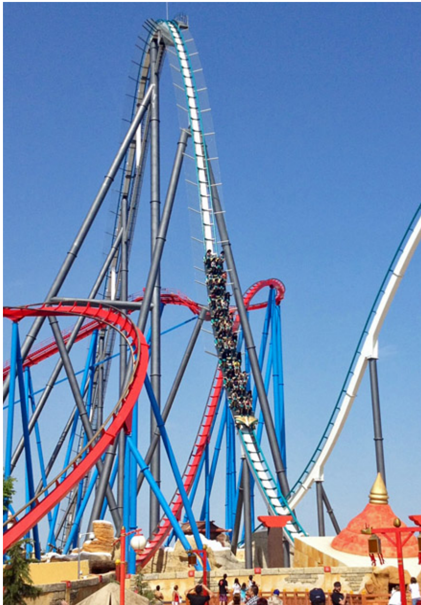
FIGURE 2 - EXEMPLE DE CHEVAUCHEMENT DE PARCOURS AVEC CONTRAINTE D'APPUIS AU SOL (PARCOURS « SHAMBHALA » ET « DRAGON KHAN » PAR B&M, PORTAVENTURA - ESPAGNE) 1
