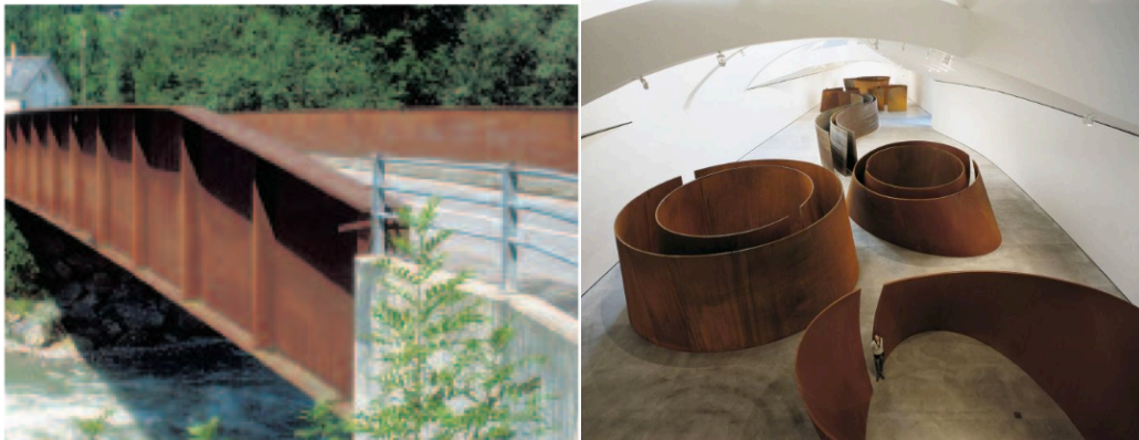
Figure 5 : (Gauche) Pont routier sur la Sarine (FR), avec poutre en acier patinable, d'après [LEB 05]. (Droite) Utilisation de l'acier Corten à des fins artistiques, exposition de Richard Serra au musée Guggenheim de Bilbao [SER 96].
