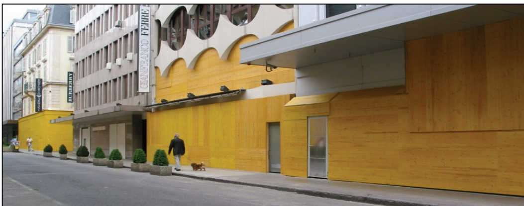
Panneaux de coffrage posés sur les vitrines genevoises (fin mai 2003), crédit PV
