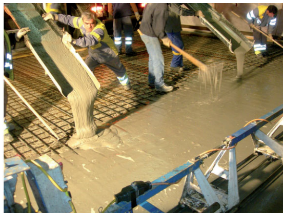
Bild 11 Querschnitt über Auflager der mit bewehrtem Stahl-UHFB verstärkten Rippendecke und Einbringen des Frisch-UHFB Cross section over support of a ribbed slab strengthened with R-UHPFRC and casting of fresh UHPFRC
