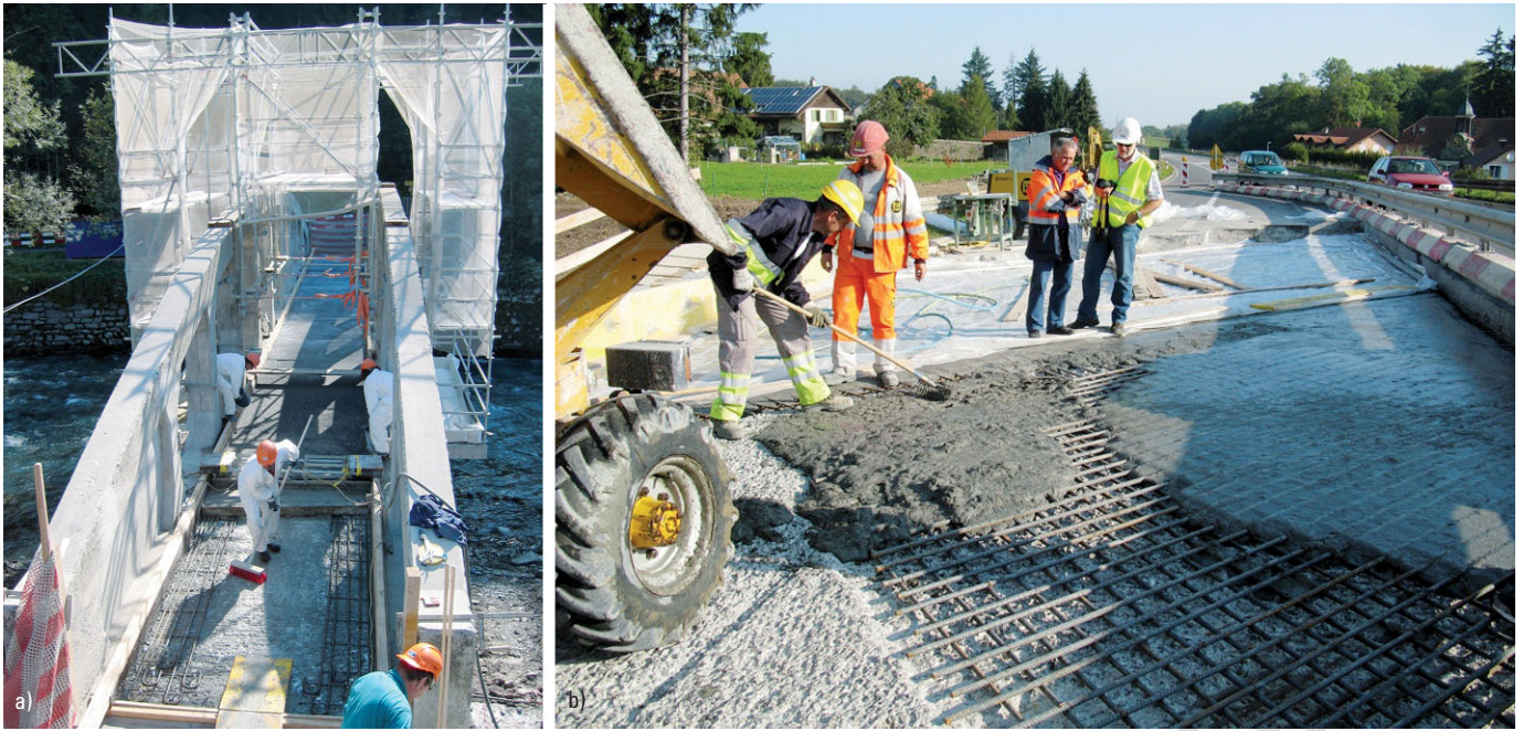
Bild 12 Trag- und Schutzfunktion durch Stahl-UHPFB: a) Fahrbahnplatte als Zuggurt einer Bogenbrücke, b) Biege- und Schub-Verstärkung über Stützen einer massiven Platte Load carrying and protection function using R-UHPFRC: a) deck slab as tensile member of an arch bridge, b) bending and shear strengthening of a massive slab over a column
