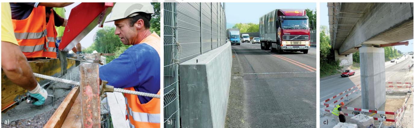
Bild 10 a) Einbringen des Frisch-UHPFB, b) Ansicht der Leitmauer mit UHPFB Beschichtung, c) UHPFB-Fertigteile ummanteln einen Brückenpfeiler a) casting of fresh UHPFRC, b) view of the crash barrier wall covered with UHPFRC layer, c) prefabricated UHPFRC shell elements as protection shield for a bridge pier
