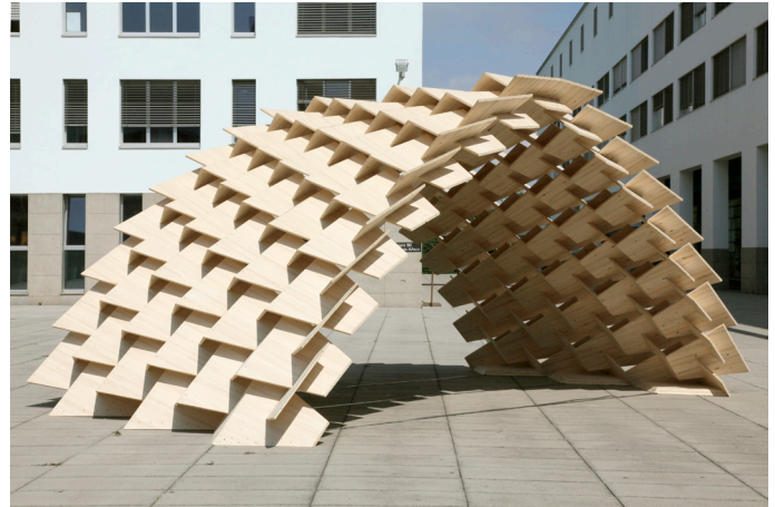
Entwurf einer Festhalle. Durch das Zusammenstecken von V-förmigen Holzmodulen entsteht eine gewölbte Gebäudehülle.
