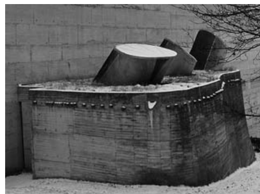
fig. 189a Sainte Marie de la Tourette, Éveux. Vue extérieure des « canons à lumière ».
