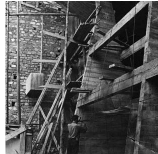
fig. 80 Chapelle Notre-Dame-du-Haut, Ronchamp. Photo de chantier, structure du mur sud.
