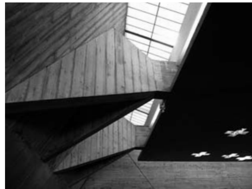
fig. 187 Christ Memorial Lutheran Church, Montréal. Détail de l'éclairage zénithal.
