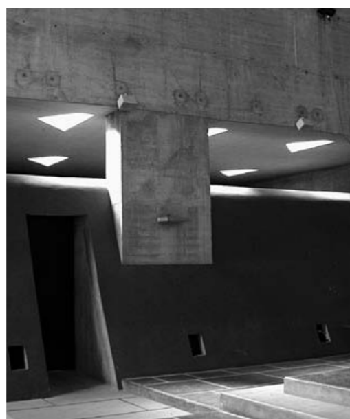
fig. 190b Sainte Marie de la Tourette, Éveux. Vue intérieure des « mitraillettes de lumière ».
