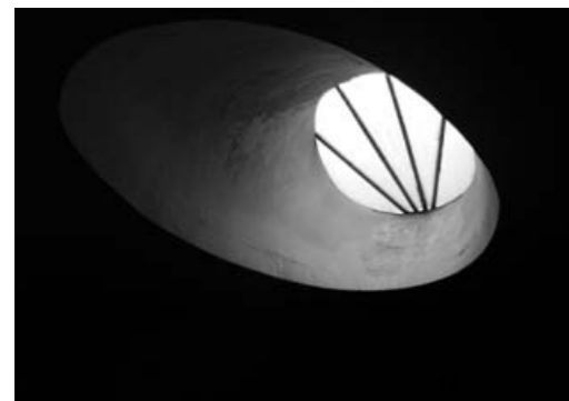
fig. 85 Église du couvent Sainte-Marie de la Tourette, Éveux, Détail d'un canon à lumière.
