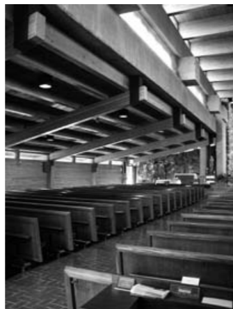
fig. 177 Saint-Maurice de Duvernay, Laval. Œuvre de Jean-Paul Mousseau insérée dans la poutre Vierendeel.
