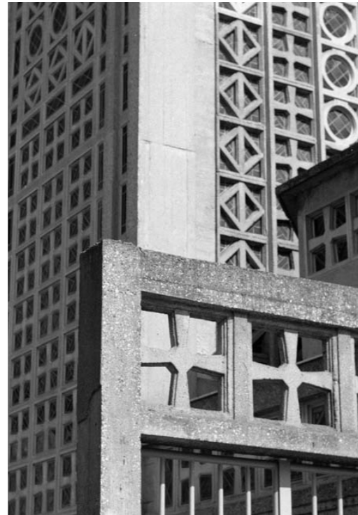
fig. 70 Notre-Dame-de-la-Consolation, Raincy. Détail extérieur des claustras.
