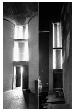
fig. 174a et 174b Notre-Dame-du-Haut, Ronchamp. Brise-soleils verticaux.
