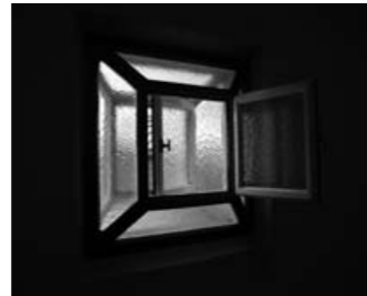
fig. 111 Église néo-apostolique de Genève. Détail d'une fenêtre ouvrante en bois et en verre cathédrale.
