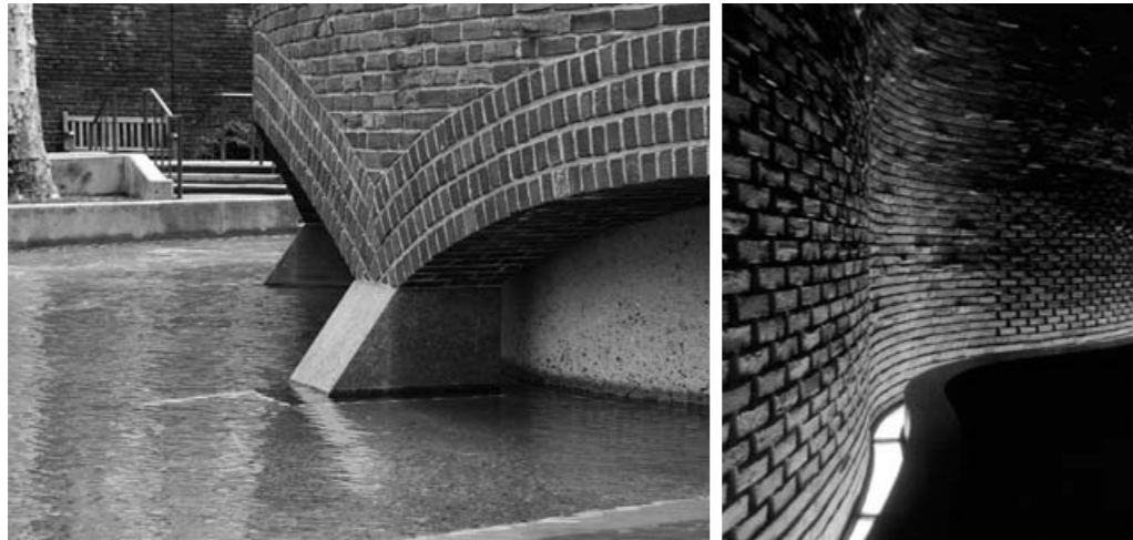
fig. 162 Kresge Chapel, MIT. Détail des piliers immergés.
