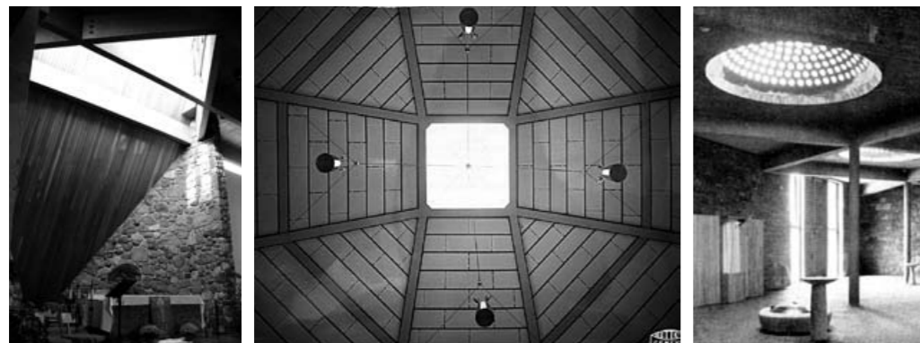
fig. 192 Saint-Maurice de Duvernay, Laval. Lanterneau au dessus du sanctuaire.
