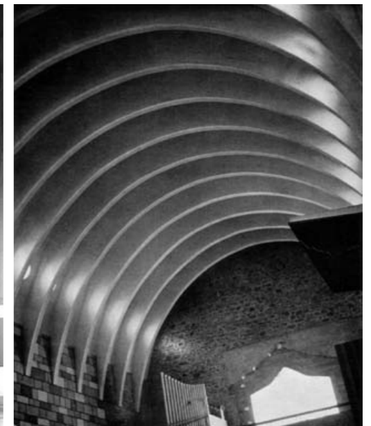
fig. 179 Église San Antonio Abate, Recoaro Terme. Vue de la voûte éclairée indirectement par les oculi.
