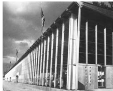
fig. 101 Pavillon du centenaire de l'aluminium (1954), monté sur les quais de la Seine, Paris, Jean Prouvé. Photo d'époque, détail des éléments de structure du pavillon en aluminium plié.
