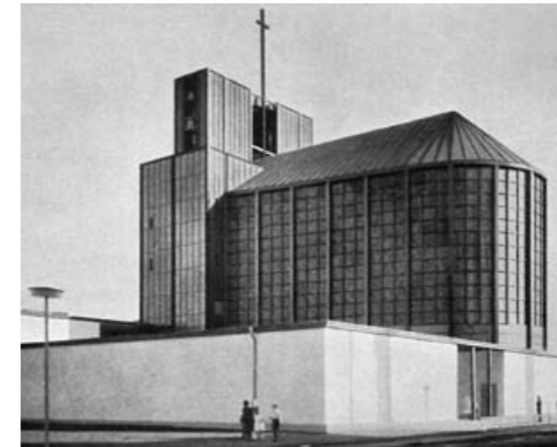
fig. 105 Stahl Kirche (1928), Cologne, Otto Bartning. Vue extérieure générale.
