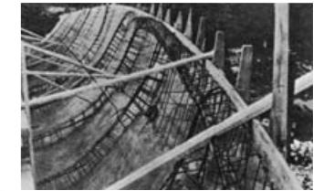
fig. 82 Chapelle de Ronchamp. Photo de chantier, coque béton de la toiture.
