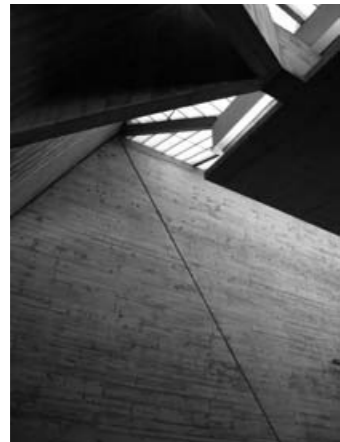
fig. 98 Église Christ Memorial Lutheran (1964-1965), Montréal, Roger D'Astous. Détail de béton. Motif des planches de coffrages.
