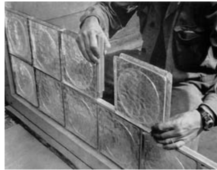
fig. 115 Pose de briques Nevada.
