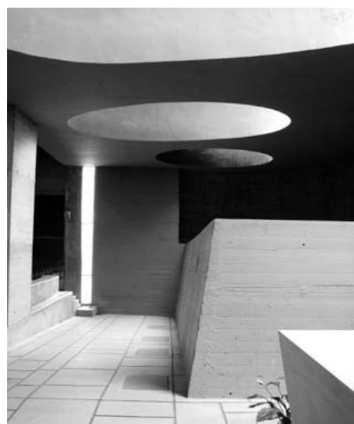
fig. 189b Sainte Marie de la Tourette, Éveux. Vue intérieure des « canons à lumière ».
