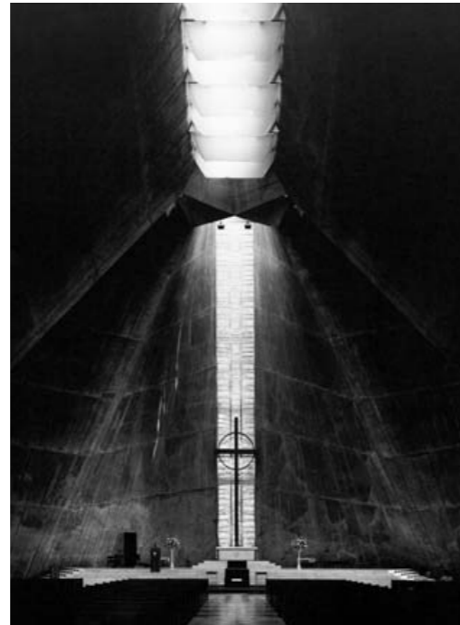
fig. 77 Cathédrale Sainte-Marie (1961-1964) Tokyo, Kenzo Tange. Vue intérieure de structure parabolique en béton armé.
