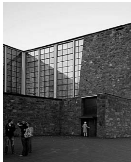
fig. 117a et 117b Église Sankt Anna, Düren. Comparatif entre la façade extérieure originale en blocs de verre et la verrière actuelle.
