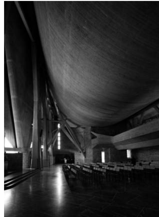
fig. 76 Église San Giovanni Battista — Chiesa dell'autostrada (1960-1964) Campi Bisenzio, Giovanni Michelucci. Vue intérieure de structure parabolique en béton armé.
