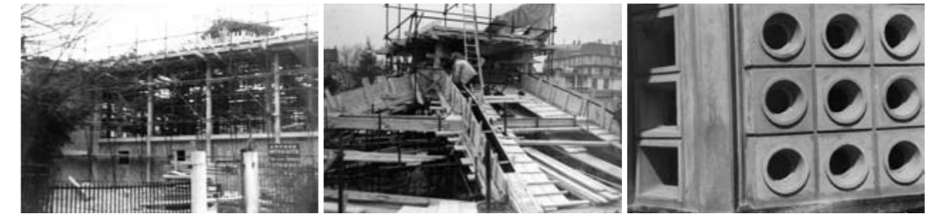
Photos de chantier
