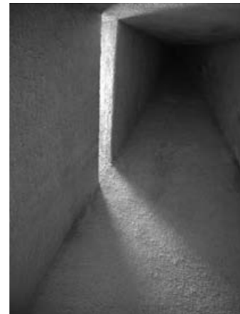
fig. 100 Oratoire du couvent Sainte-Marie de la Tourette, Éveux. Texture baveuse du béton projeté qui accroche la lumière.
