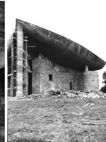
fig. 81 Chapelle de Ronchamp. Photo de chantier, murs en remplissage des pierres de l'ancienne chapelle.
