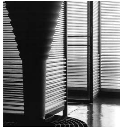
fig. 118 Johnson Wax Headquarters (1936-1939), Racine (Wisconsin), Frank Lloyd Wright. Détail d'une paroi translucide en tubes de pyrex.
