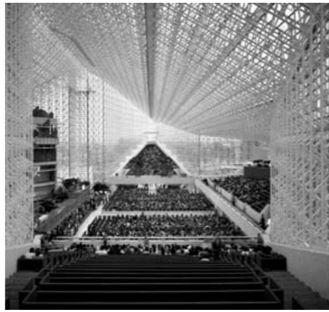
fig. 104 Crystal Cathedral (1977-1980), Garden Grove (Californie), Philip Johnson. Vue intérieure de l'étendue de la nef en structure triangulée.
