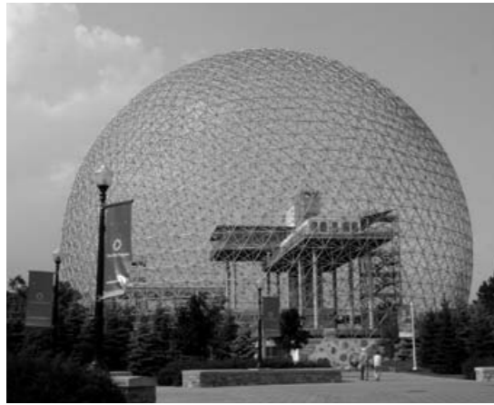
fig. 103 Pavillon des USA (1967), exposition internationale de Montréal, Buckminster Fuller. Désormais musée de la biosphère, reconverti par l'architecte Eric Gauthier. Photo actuelle, vue générale du bâtiment.
