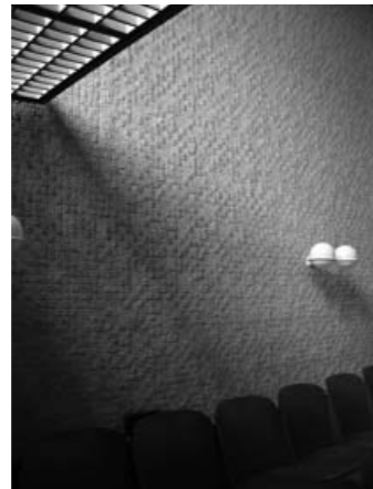
fig. 99 Église réformée d'Altstetten (1938-1942) Zurich-Altstetten, Werner M. Moser. Détail d'un mur en béton texturé.
