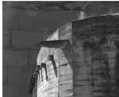
fig. 96 Église du couvent Sainte-Marie de la Tourette, Éveux. Détail de béton à la texture brute de décoffrage.
