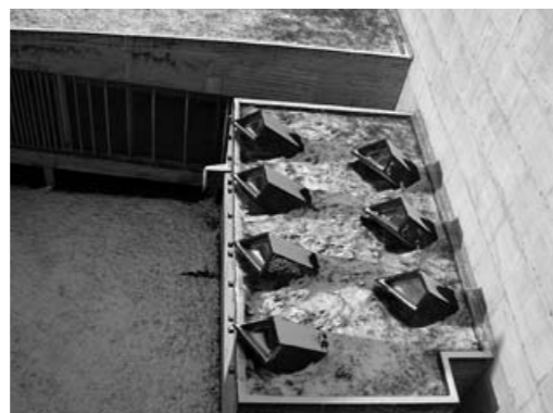
fig. 190a Sainte Marie de la Tourette, Éveux. Vue extérieure des « mitraillettes de lumière ».
