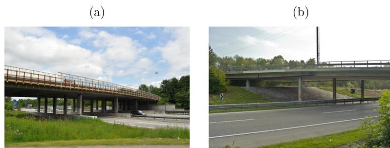
**Figure 1.7:** Exemple de ponts-dalles à Copenhague au Danemark (a) et à Genève en Suisse (b)
