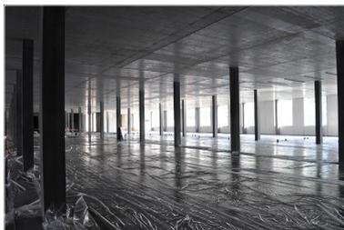
**Figure 1.5:** Bâtiment en phase de construction utilisant le système porteur de plancher-dalle avec le risque de poinçonnement sous-jacent
