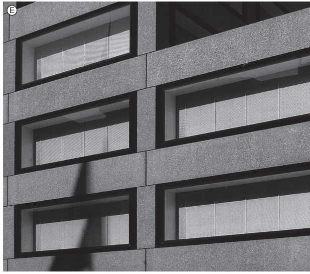
OSSATURE + PANNEAUX BANQUE PICTET, GENEVE, 2005
