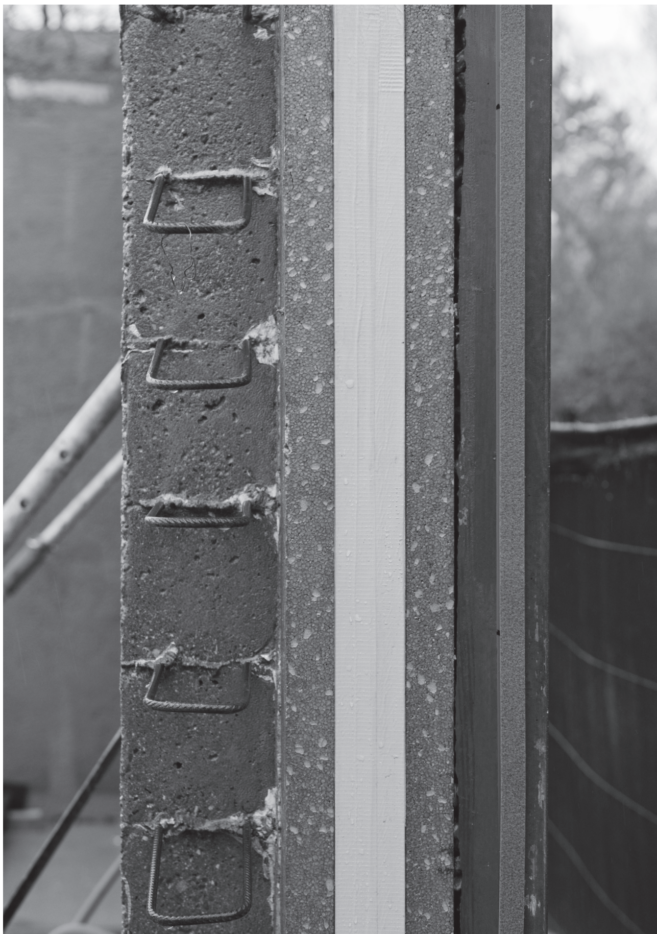
Tranche d'un panneau porteur en béton préfabriqué et à haute performances thermiques (projet pilote)
