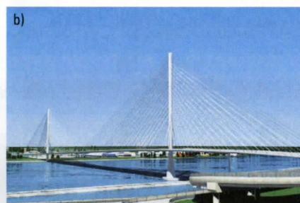
Bild 4. Peace Bridge bei Buffalo: Christian Menns Entwürfe (2001–06) für a) eine neue Schrägkabelbrücke mit „Spindel“-Pylonen neben der bestehenden Stahlbogenbrücke, b) eine neue Schrägkabelbrücke als Ersatzbau und c) leicht gekrümmte Dreipylon-Schrägkabelbrücke
