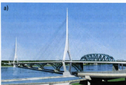
Bild 4. Peace Bridge bei Buffalo: Christian Menns Entwürfe (2001–06) für a) eine neue Schrägkabelbrücke mit „Spindel“-Pylonen neben der bestehenden Stahlbogenbrücke, b) eine neue Schrägkabelbrücke als Ersatzbau und c) leicht gekrümmte Dreipylon-Schrägkabelbrücke
