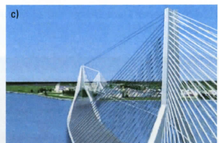
Bild 4. Peace Bridge bei Buffalo: Christian Menns Entwürfe (2001–06) für a) eine neue Schrägkabelbrücke mit „Spindel“-Pylonen neben der bestehenden Stahlbogenbrücke, b) eine neue Schrägkabelbrücke als Ersatzbau und c) leicht gekrümmte Dreipylon-Schrägkabelbrücke
