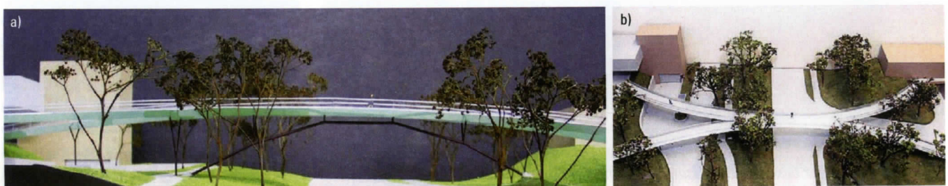
Bild 6. Fußgängerbrücke über die Washington Road: a) Stabbogen, b) X-förmiger Grundriss
