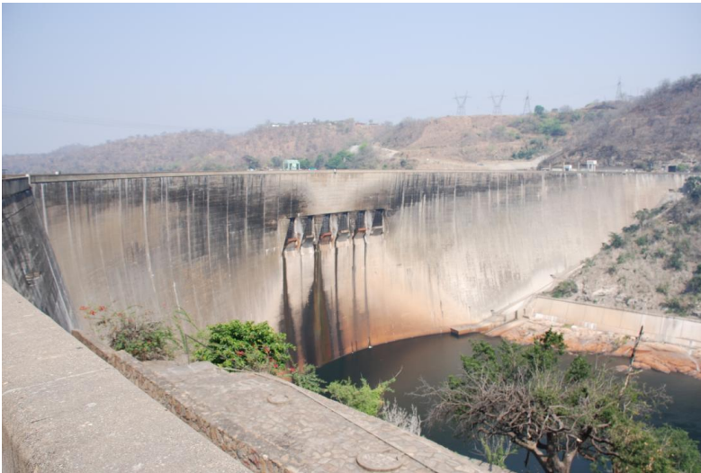
Fig. 1 General view of Kariba Dam Vue générale du barrage de Kariba
