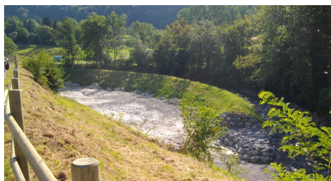
Fig. 19 Vue d'aval de la zone d'épandage, avec l'ouvrage de sortie (en bas à droite)
