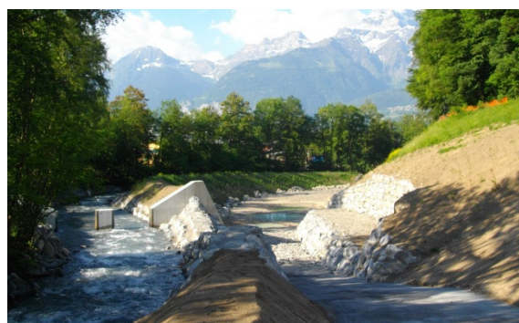
Fig. 18 Vue amont du seuil à engravures (à gauche) et de la zone d'épandage (à droite)
