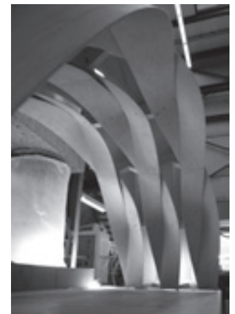
Bogenkonstruktion aus verflochtenen Holzstreifen, IBOIS, EPFL
