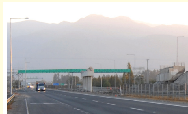
Bild 14. Eingestürzte Überführung bei Ranagua. Die heruntergefallenen Träger sind weggeräumt und eine provisorische Fußgängerpasserelle führt über die Autobahn.
