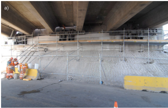
Bild 15. Reparatur der Überführung bei Rengo. Stahlseile entlang der Widerlagerbank zum Zurückschieben der Träger (a) und Montage von Z-förmigen Haken auf dem Stützenjoch zur Lagerung der Stahlseile (b).
