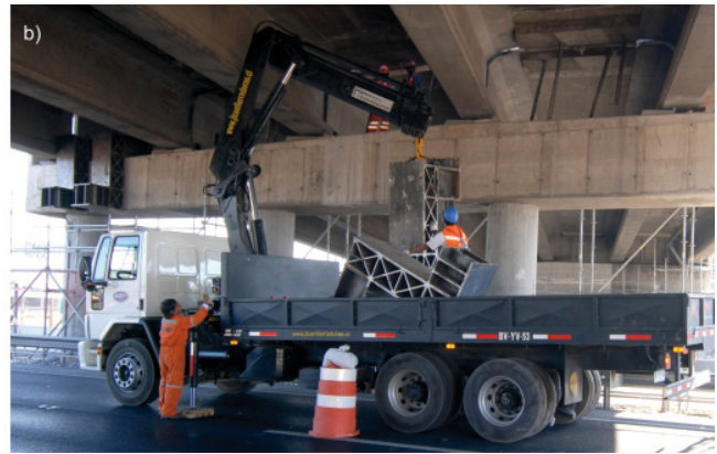
Bild 15. Reparatur der Überführung bei Rengo. Stahlseile entlang der Widerlagerbank zum Zurückschieben der Träger (a) und Montage von Z-förmigen Haken auf dem Stützenjoch zur Lagerung der Stahlseile (b).
