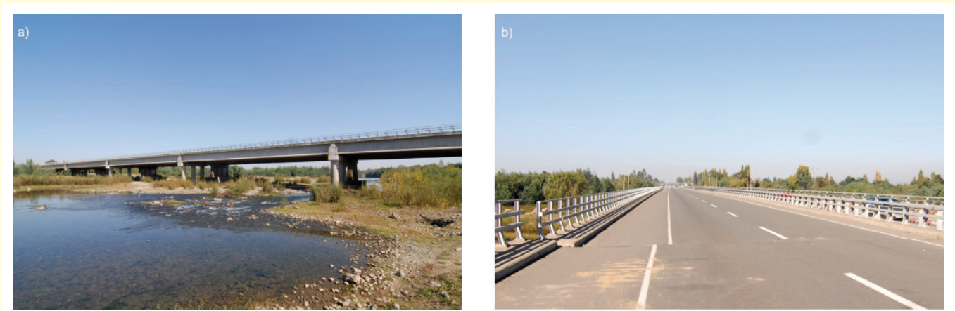
Bild 7. Querverschiebung der Autobahnbrücke „Puente Perquilauquéu“: Ansicht (a), Querversatz des Geländers und der Sicherheitslinie bei der Dilatationsfuge (b).
