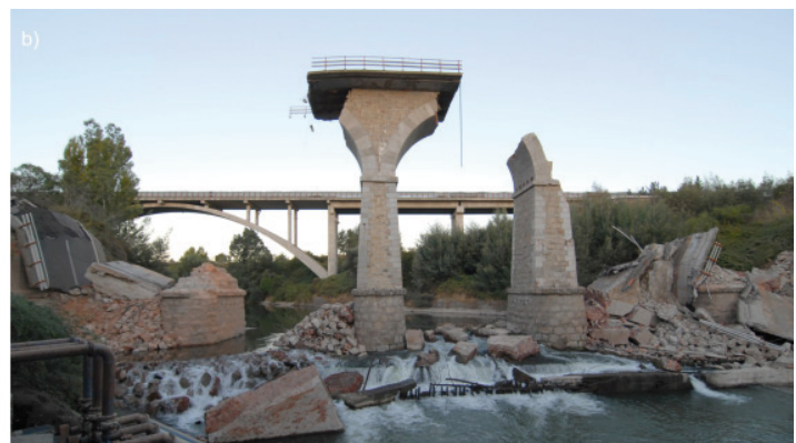
Bild 2. Eingestürzte 7-feldrige Bogenbrücke aus Natursteinmauerwerk über den Rio Claro: Ansicht vor (a) und nach (b) dem Erdbeben.
