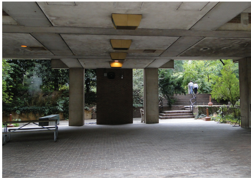
fig. RGL 47. Le passage au-dessous de l'unité centrale des laboratoires.
