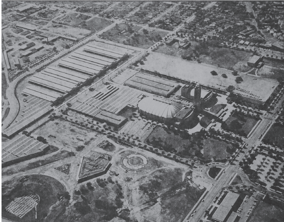
fig. KIM 14. L'une des photos aériennes du centre Will Rogers que Louis Kahn possédait. (Dossier 030.I.C.730.001, Louis I. Kahn Collection, University of Pennsylvania and Pennsylvania Historical and Museum Commission.)
