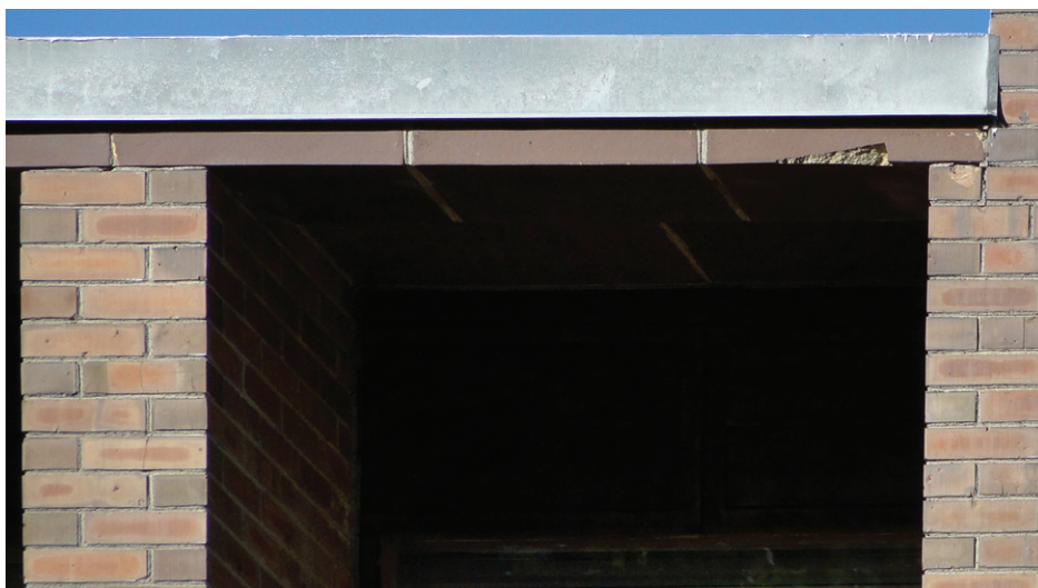
fig. ROC 49. Détail du linteau dans le bâtiment original.
