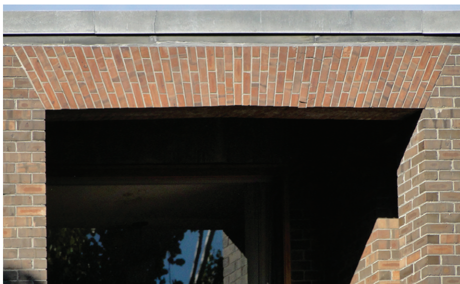
fig. ROC 50. Arc en plate-bande dans l'extension.
