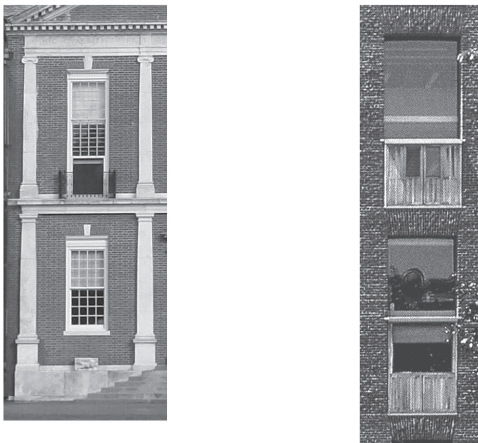
fig. EXE 37. Fenêtres du bâtiment principal de l'académie (à gauche, RZ et premier étage) et de la bibliothèque d'Exeter (à droite, étage noble et deuxième étage).
