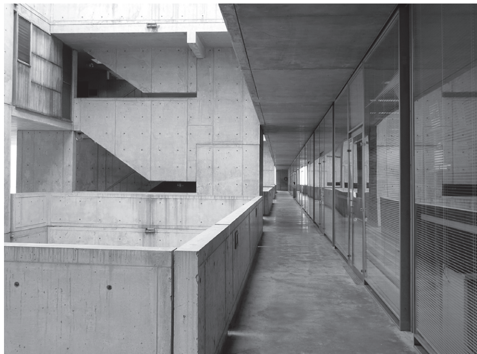
fig. SLK 47. Paroi vitrée des laboratoires.
