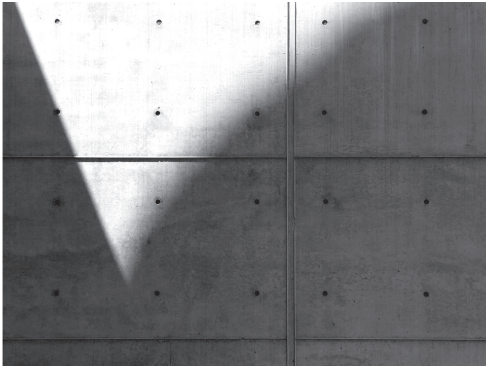
fig. KIM 47. Kimbell Art Museum. Fragment du mur porteur en béton.
