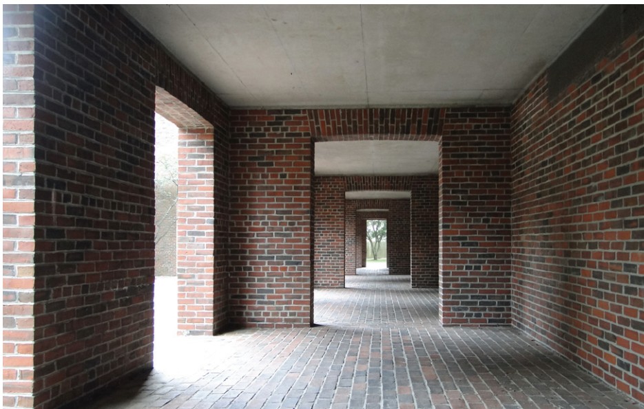
fig. EXE 30. Bibliothèque d'Exeter. Portique.
