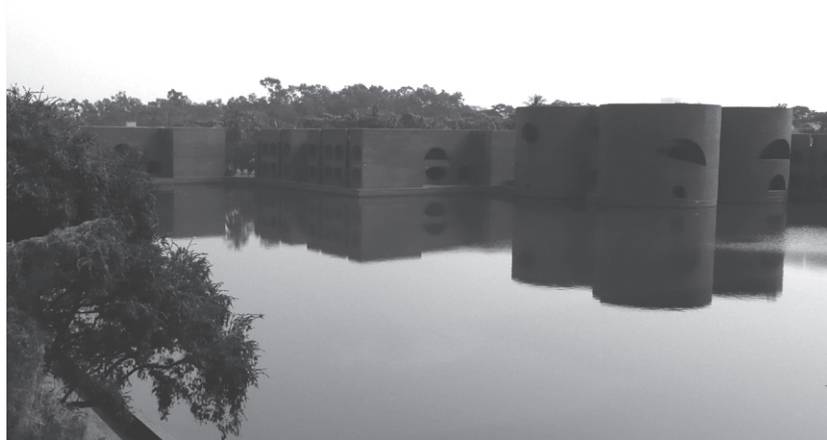
fig. II 35. Hôtels du Capitole de Dhâka, Bangladesh, construit en 1962-83.
