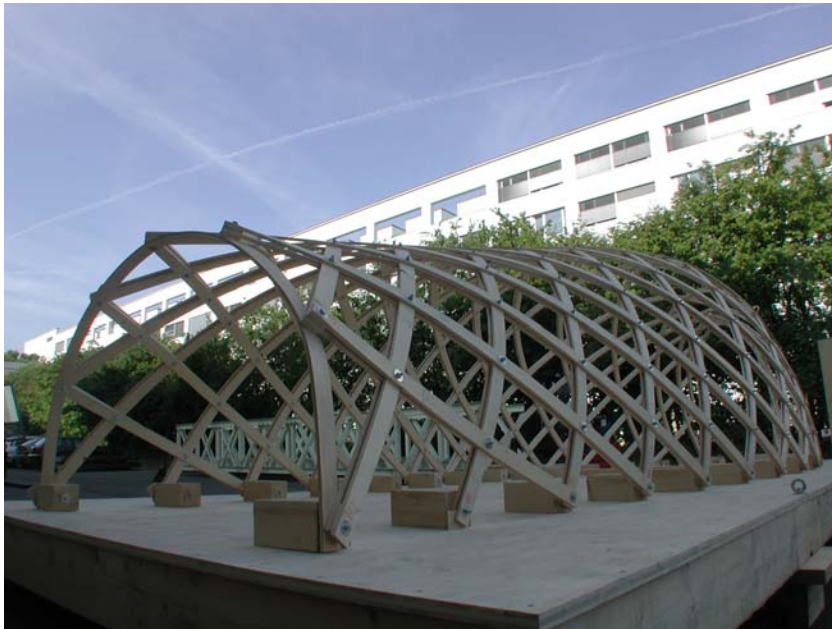
Abbildung 2: Versuchsschale in Brettrippenbauweise
