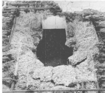
b) Feine Bruchstücke sind mit dem Staubsauger entfernt worden
