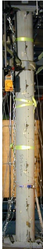
Abbildung 57: Bruch am Fuss der Stütze
