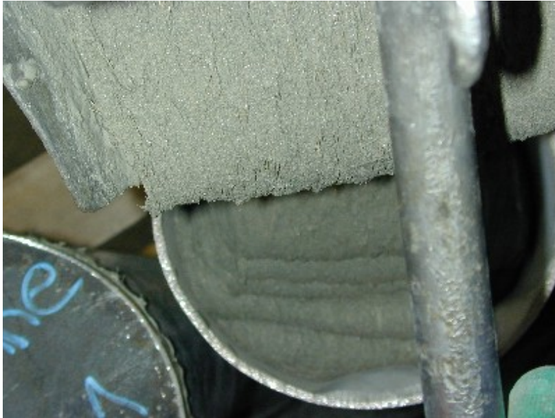
Abbildung 6: Der UHFFB füllt die Schalung in Schichten. Die Faltung ist in dieser Aufnahme gut zu erkennen
