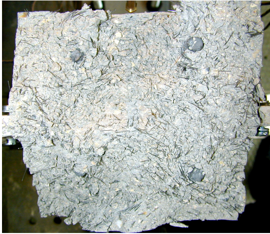
Bild 22: Bruchfläche des vollständig getrennten Versuchskörpers
