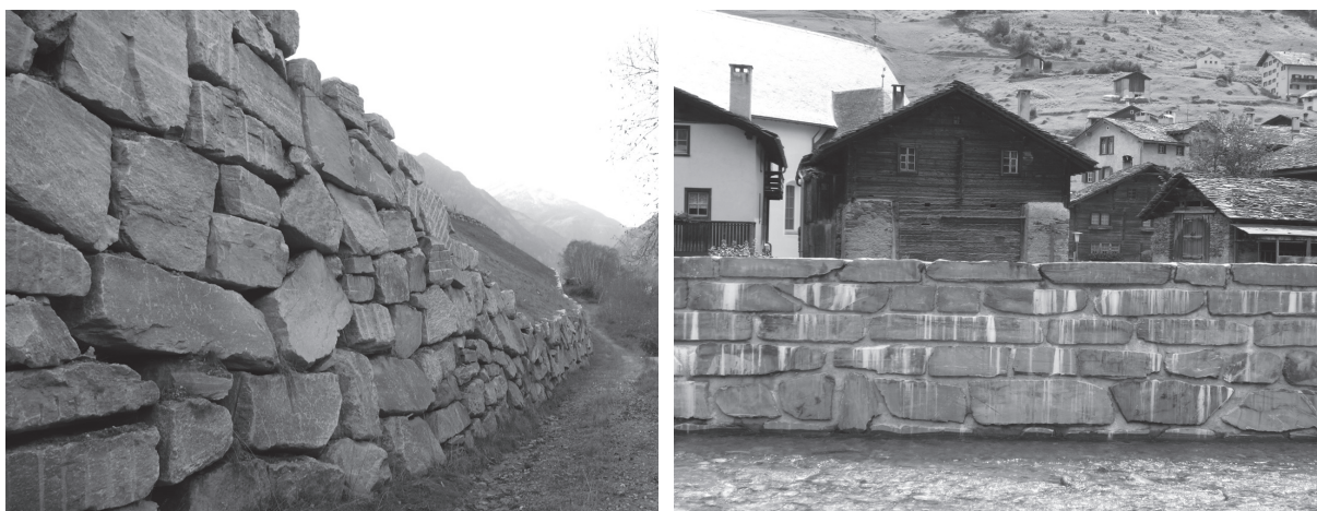
Fig. III.28-29. Mur de soutènement en gros blocs de gneiss dans une carrière remise en état de nature à Iragna, Canton du Tessin (Barbara Tirone 2009). Jürg Conzett, nouveaux murs des berges du fleuve Rhin à Vals, Canton des Grisons, 2008: blocs en gneiss de Vals avec faces sciées (Marco Svimmersky 2009)
