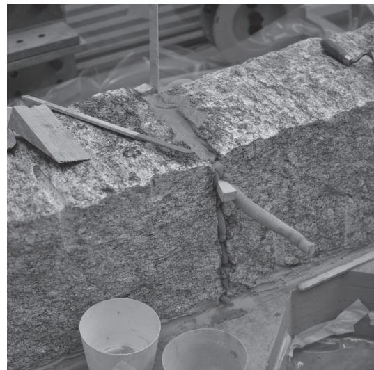
Coulage des joints verticaux avec un mortier fin
