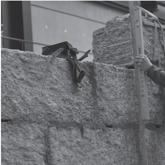
Vérification de l'aplomb du mur et du bloc
