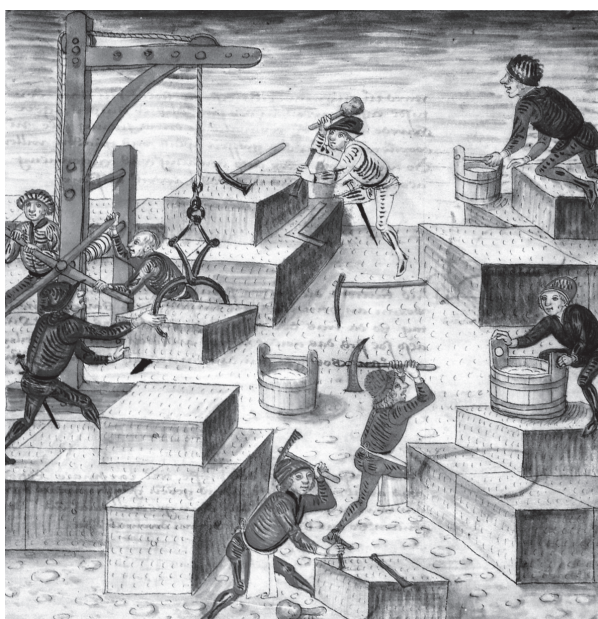
Fig. II. 1. Début du chantier de la collégiale de Berne, vers 1420. Extrait de Diebold Schilling, Amtliche Chronik , 1, p.451. [Andermatten, B., De Ramey, D., éd. 1990]
