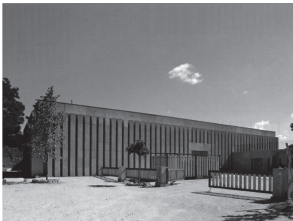
Fig. 2-3-4. Gilles Perraudin: chai viticole à Vauvert 1998 [Pavan, V., éd. 2001]; chai viticole à Nizas, 2001 [Pisani, M., éd. 2002] et chai viticole de Solan, 2003-2007 [Bucci, F. 2009].
