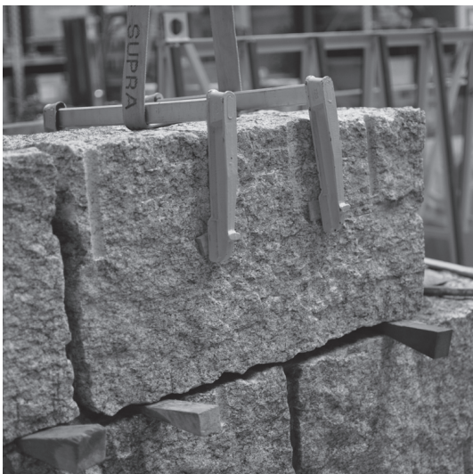
Mise en place définitive du bloc
