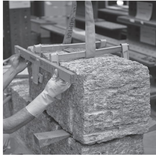
Vérification du niveau horizontal
