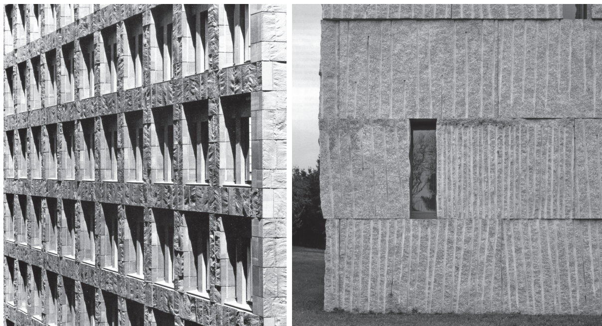
Fig. III.26-27. Peter Celsing, Riksbank, Stockholm, 1968-1974: façade en granite noir de Göinge [Erup, L. 1984]. Antón García-Abril, Centre des hautes études Musicales, Santiago de Compostela, 1999-2004: façade en blocs massifs de granite Mondariz [Detail 2006]
