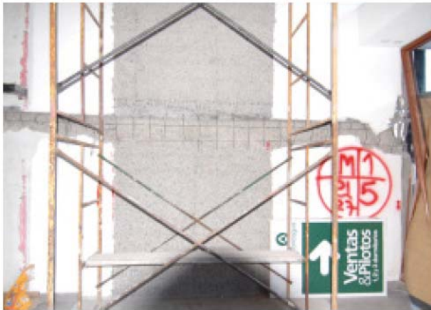
Bild 7. 21-stöckiges Stahlbetontragwandgebäude Salas 445 in Concepción: Die Rückseite der beschädigten Wand von Bild 5b und c wurde aufgeraut als Vorbereitung für eine Aufdoppelung.
