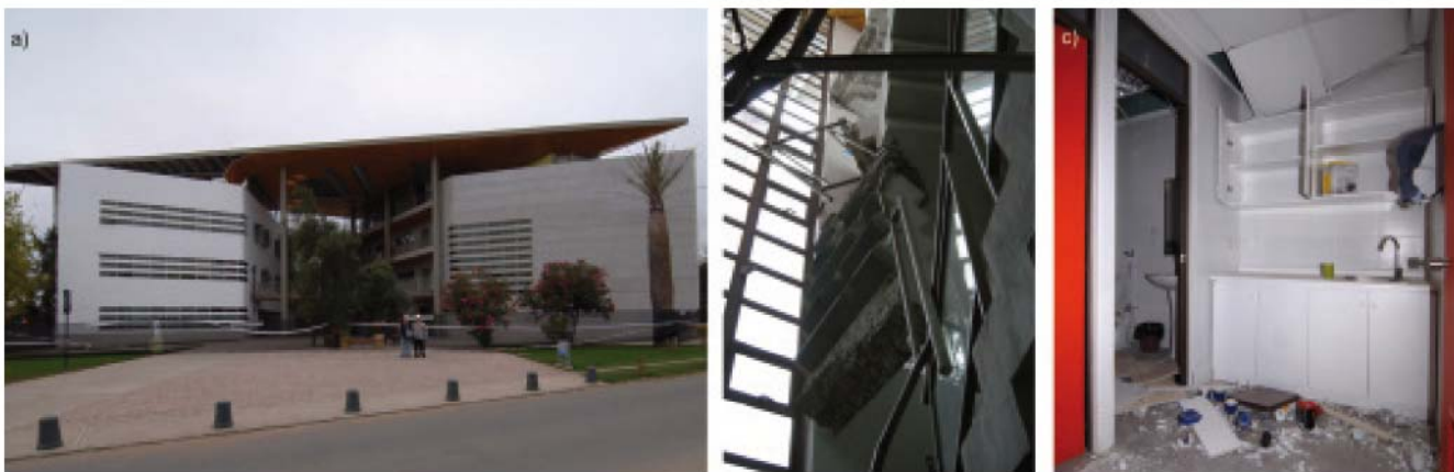
Bild 11. Gebäude für Grundlagenwissenschaften der Universität in Talca: Ansicht (a), Treppenhaus (b) und Teeküche (c).
