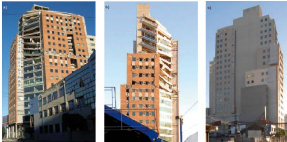
Bild 10. 20-stöckiges Stahlbetontragwandgebäude O'Higgins in Concepción: Vorder-, Seiten- und Rückansicht.
