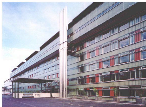
Réalisation du bâtiment OFS 1 entre 1993 et 1998 (photo R. Walti)
