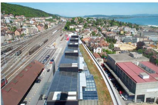
Energie : Toiture solaire de l'OFS 1 (hiver)
