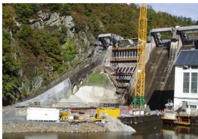
Figure 11: Coupe du PK-WEIR sur un bac de sortie (à gauche) et vue depuis l'aval durant la construction (à droite)
