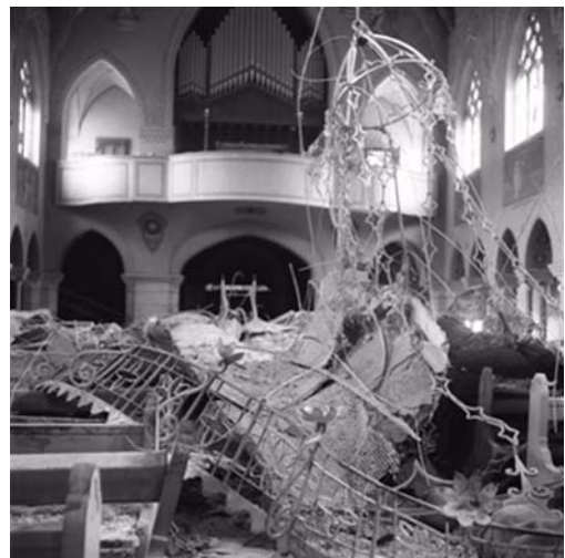
Bild 3.2: Eingestürzte Decke der Kirche von Chippis beim Erdbeben von 1946 (Keystone)
