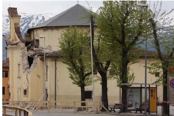
Bild 6.87: Chiesa della Concezione: Auskippen der gesamten Fassade gem. Mechanismus K1 (XMI_2605)
