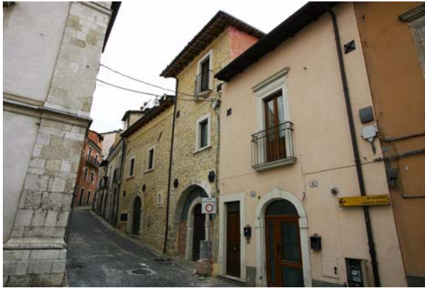
Bild 4.13: Saniertes Bruchsteinmauerwerksgebäude im Stadtzentrum von L'Aquila (AD0477)
