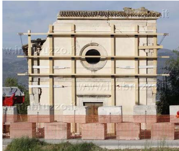
Bild 6.80: Chiesa Santa Maria degli Angeli: Grosse Risse und Ablösen der Fassadenwand, Teileinsturz des Daches gem. Mechanismen K1 und K3 ( http://www.inabruzzo.it )
