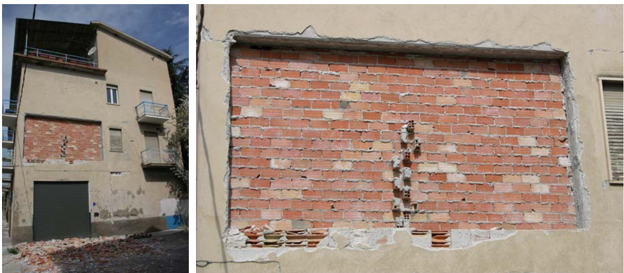
Bild 5.44: Älteres Stahlbetonrahmengebäude mit zweischaliger Mauerwerksausfachung (AD0063, AD0064)
