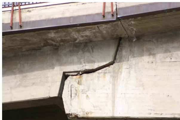
Bild 5.63: Stadtbrücke: Auflager des eingehängten mittleren einfachen Balkens (AD0519)
