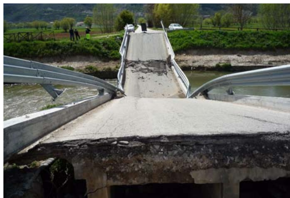
Bild 5.56: Kleine eingestürzte Brücke: Querschnitt des Brückenträgers (FBR_P1000158)
