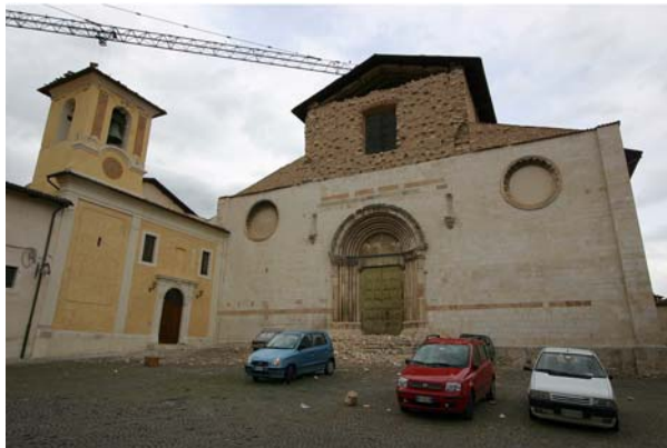
Bild 6.71: Ansicht auf die zweite Kirche und das benachbarte Kloster mit Schäden am Glockenturm gem. Mechanismus K16 (AD0484, AD0483)
