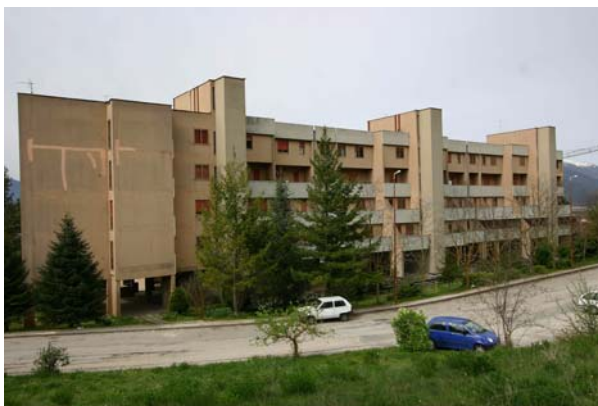
Bild 5.48: MFH 1 mit Stahlbetonwänden: Ansicht der Vorderseite (AD0398)
