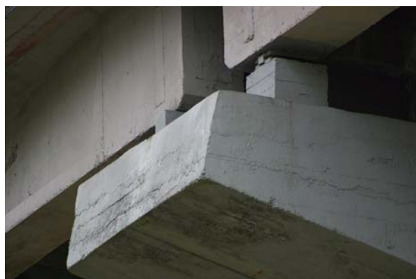
Bild 5.67: Autobahnbrücke nahe des Epizentrums: Nahaufnahme des Kipplagers (AD0163)
