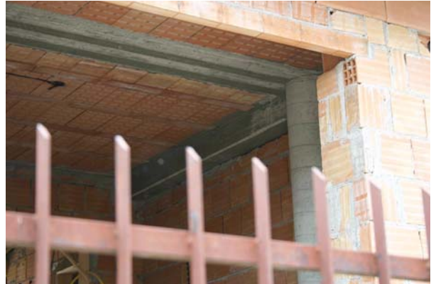
Bild 4.31: Sich noch im Bau befindendes modernes Mauerwerksgebäude mit Stahlbetonelementen in L'Aquila (AD0150, AD0140, AD0141, AD0143)
