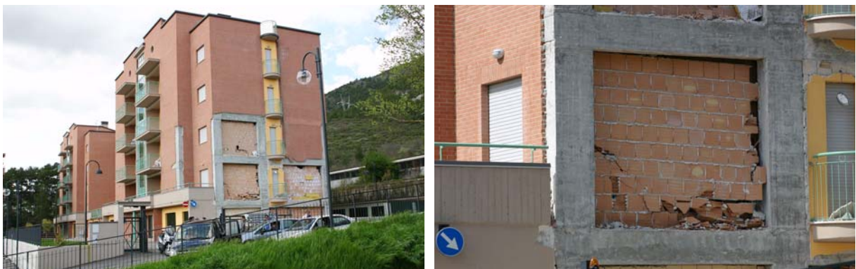
Bild 5.42: Neues Stahlbetonrahmengebäude mit unbeschädigter Tragstruktur (AD0266, AD0268)
