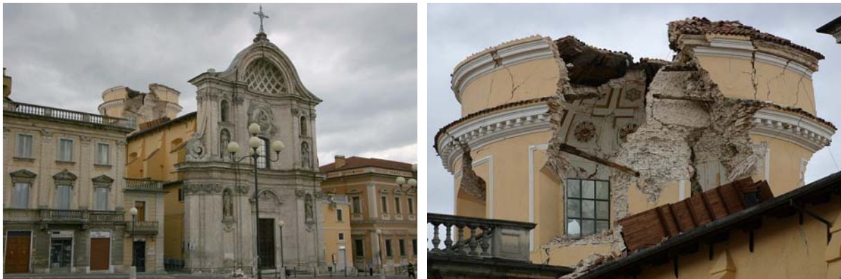
Bild 6.60: Ansicht an die Hauptfassade mit der im Hintergrund gem. Mechanismus K11 und/oder K12 eingestürzten Apsis (AD0566, AD0568)
