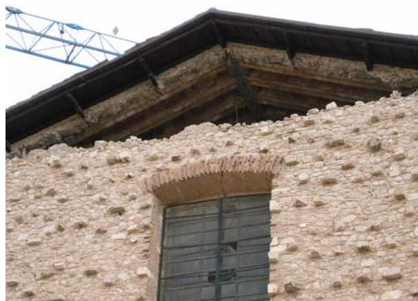
Bild 6.72: Auskippen der Giebelwand der Kirche gem. Mechanismus K2 (AD0876, AD0877)
