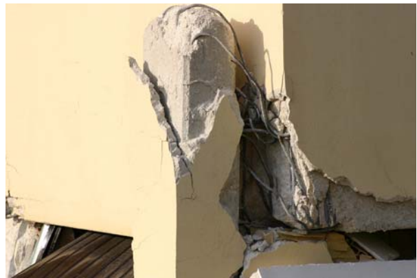
Bild 5.28: MFH 2: Rahmenknoten in Bild 1.22 vorne rechts (AD0215)
