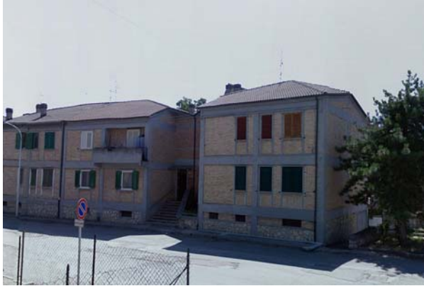
Bild 5.1: Zweigeschossiges Stahlbetonrahmengebäude: Vor dem Erdbeben (SV0202 [SV09])
