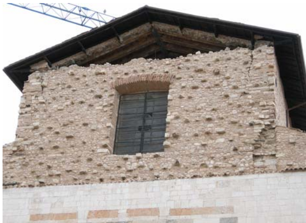
Bild 6.72: Auskippen der Giebelwand der Kirche gem. Mechanismus K2 (AD0876, AD0877)
