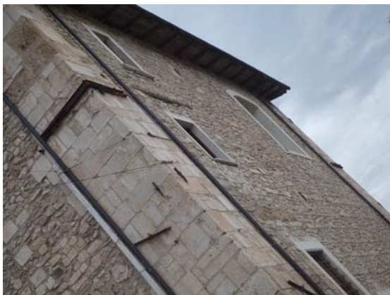
Bild 6.88: In der oberen Seitenwand der Kirche sind Teile herausgefallen gem. Mechanismus K13 (XMI_2608). Am Pfarrhaus aussen sichtbare Befestigungen von Ankerköpfen; Eckpfeilern des Pfarrhauses als Sicherungsmassnahmen mit Stahlelementen zusammengebunden (FBR_P1000280, FBR_P1000287, FBR_P1000286)
