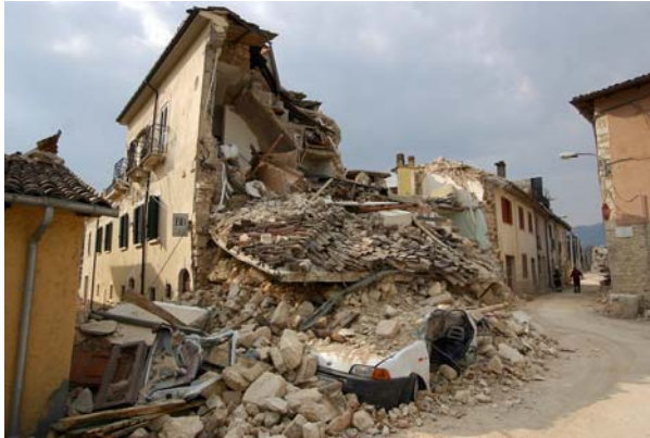
Bild 3.15: Typische Gebäude von Onna, die ein sehr unterschiedliches Erdbebenverhalten hatten (AD0013)
