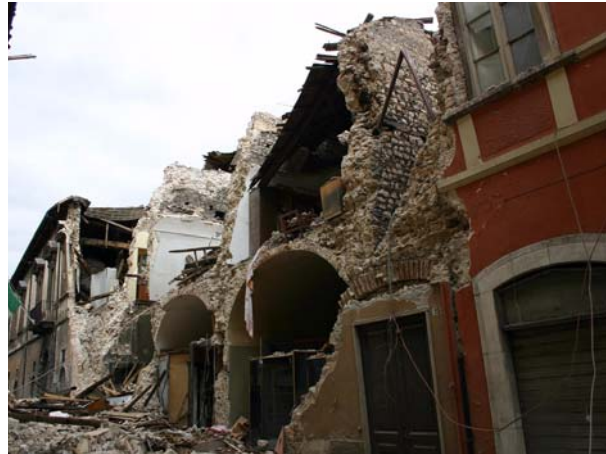
Bild 4.18: Stabil gebliebene Bogenstruktur in einem Bruchsteinmauerwerksgebäude im Stadtzentrum von L'Aquila (AD0465)
