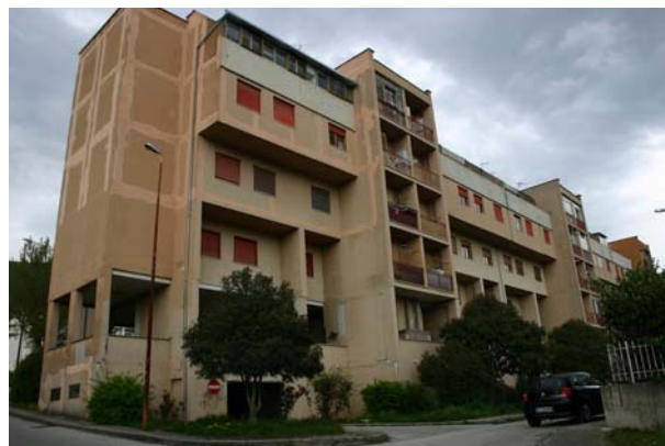
Bild 5.49: MFH 1 mit Stahlbetonwänden: Ansicht der Rückseite (AD0173)
