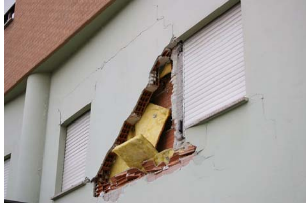
Bild 5.46: Relativ neues Wohngebäude mit zweischaliger Mauerwerksausfachung und Dämmmaterial zwischen den zwei Schalen (AD0193, AD0195)
