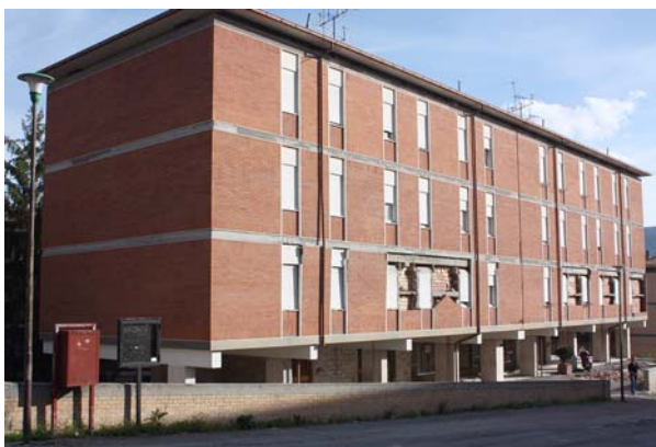
Bild 3.25: Stahlbetonrahmengebäude in L'Aquila mit offenem Erdgeschoss (XMI_2573_1)
