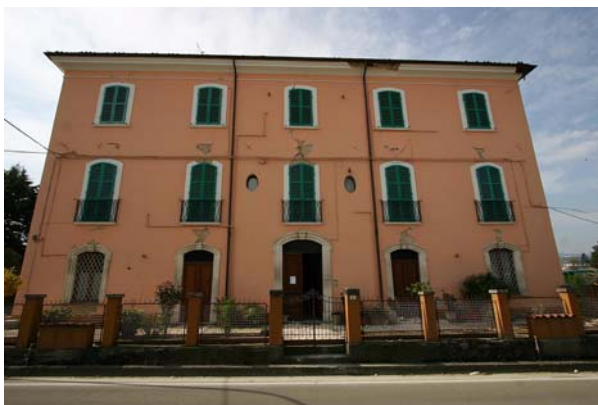
Bild 4.23: Wohnhaus aus altem Ziegelsteinmauerwerk in L'Aquila (AD0060)
