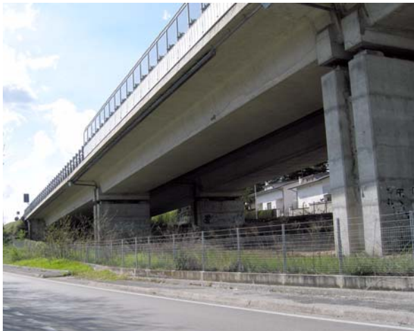
Bild 3.19: Viadukt San Sisto der Roma-Pescara Autobahn in L'Aquila mit vorgefertigten Einfeldträgern gebaut (KB0848)
