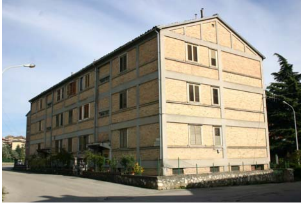
Bild 5.7: Dreigeschossiges Stahlbetonrahmengebäude: Ansicht (AD0321)
