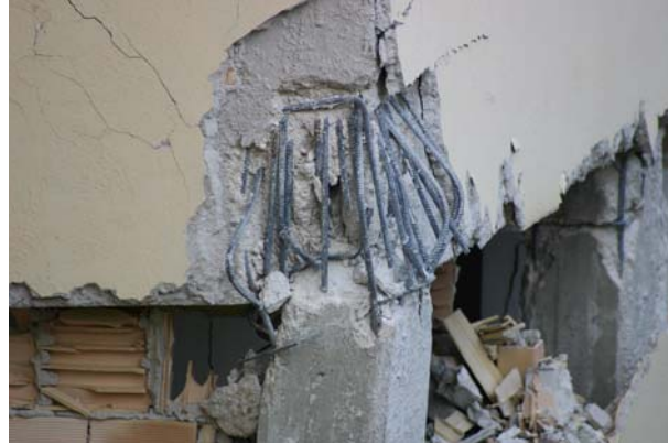
Bild 5.26: Rahmenknoten auf der Rückseite (AD0220)
