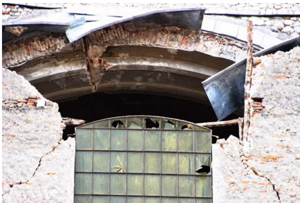
Bild 6.43: Detailansichten der Schäden an der Kirche nach dem Erdbeben: Auskippen eines Fassadenteils gem. Mechanismus K3 im Bereich einer (nachträglich verschlossenen) Öffnung, lokaler Querschnittsaufbruch im Bogenmauerwerk erkennbar (AD0456, AD0457, AD0458, AD0459)
