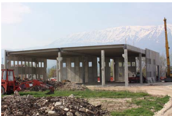
Bild 3.21: Vorgefertigte Stahlbetonhalle im Industriegebiet von Bazzano (XMI_2457_1)
