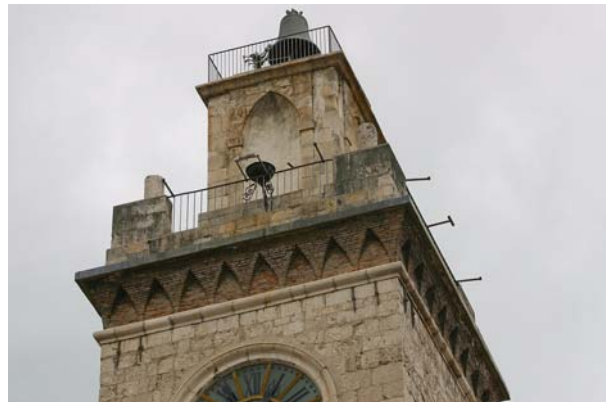
Bild 6.94: keine sichtbaren Schäden im oberen Bereich des Glockenturms (AD0445)
