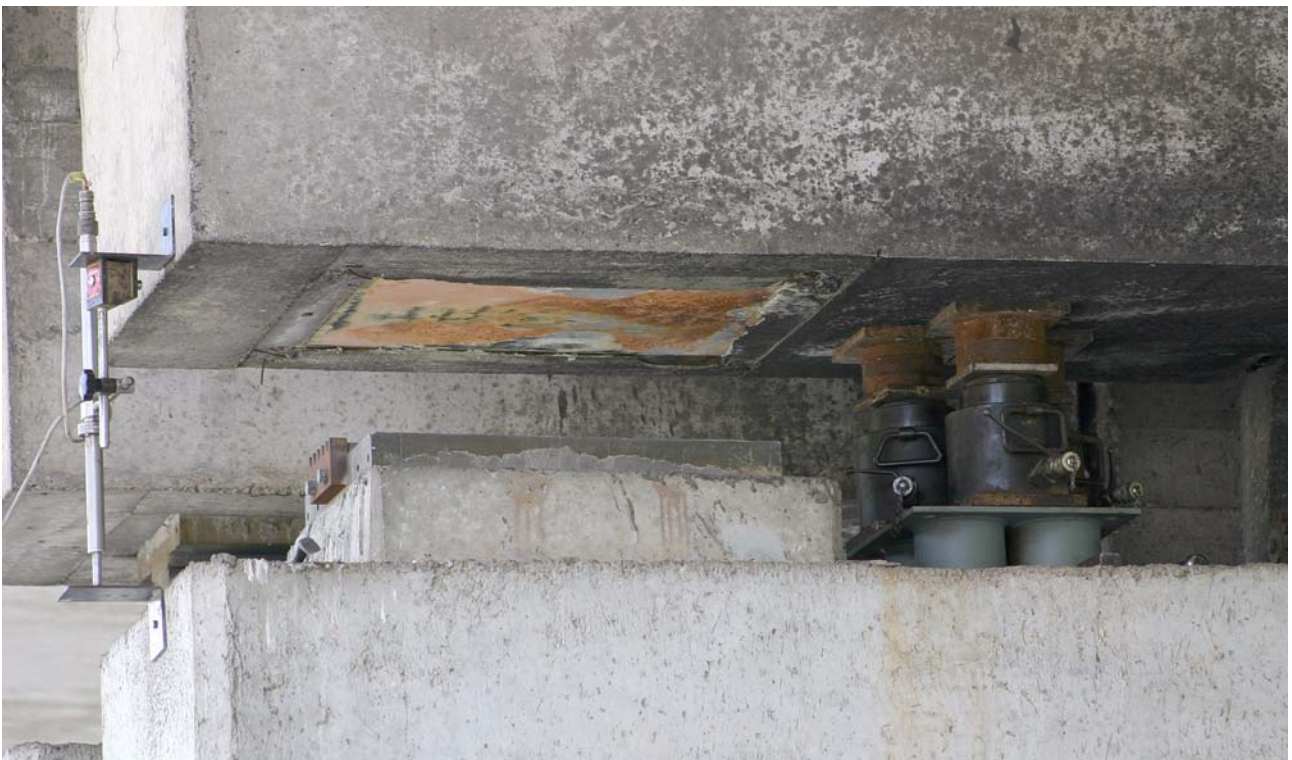
Austausch von beschädigten Lager beim Viadotto San Sisto am 17. April 2009
