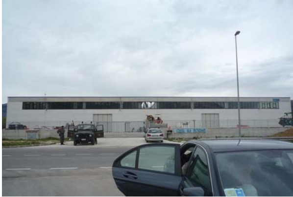
Bild 3.23: Vorfabrizierte Stahlbetonhalle im Industriegebiet von Bazzano (FBR_P1000304)
