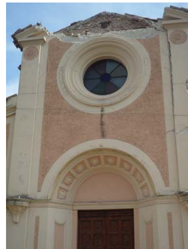
Bild 6.80: Chiesa Santa Maria degli Angeli: Grosse Risse und Ablösen der Fassadenwand, Teileinsturz des Daches gem. Mechanismen K1 und K3 ( http://www.inabruzzo.it )
