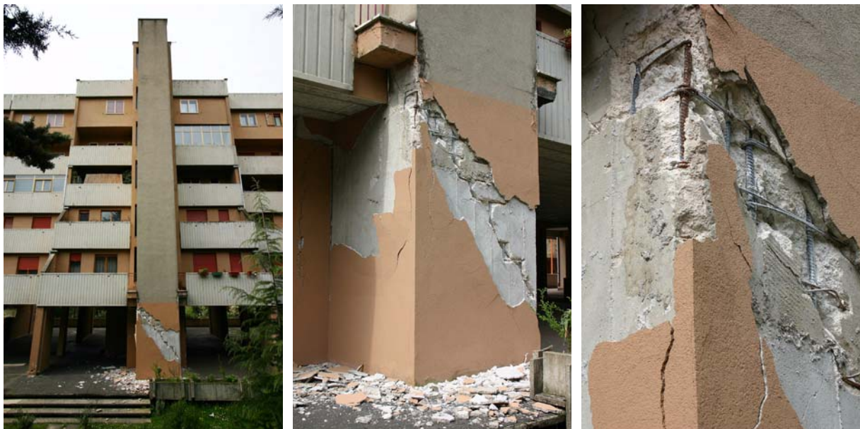
Bild 5.54: MFH 2 mit Stahlbetonwänden: Liftschacht (AD0393, AD0394, AD0395)
