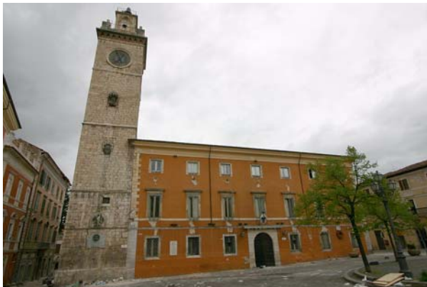
Bild 6.93: Sichtbare Abplatzungen im Bereich der Kopplungsriegel auf Deckenhöhe (Kopfanker) in Aussenwand gem. Mechanismus P10 (AD0444)
