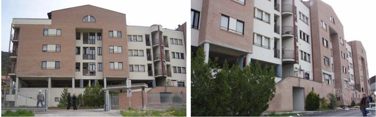
Bild 5.40: MFH mit weichem Erdgeschoss: Ansichten (SFR_2024, XMI_2589)
