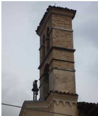
Bild 6.83: Weitere Kirche in Monticchio ohne sichtbare Schäden am Kirchbau oder Turm; An den Pfeilern des Turmes sind Sicherungsmassnahmen in Form von Stahlbändern, an der Seitenwand der Kopfe eines Ankers zu erkennen (FBR_P1000308, FBR_P1000309, FBR_P1000318, FBR_P1000319)
