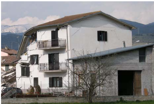
Bild 4.25: Wohngebäude in Onna aus Mauerwerk mit Betonsteinen (KB0661)
