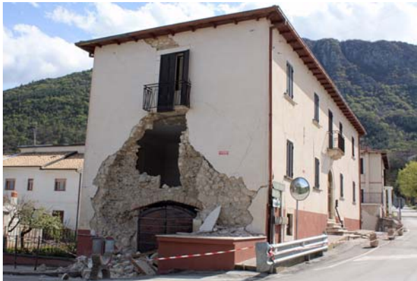
Bild 3.17: Ländliches Haus in Casentino, Umland von L'Aquila (XMI_2560)
