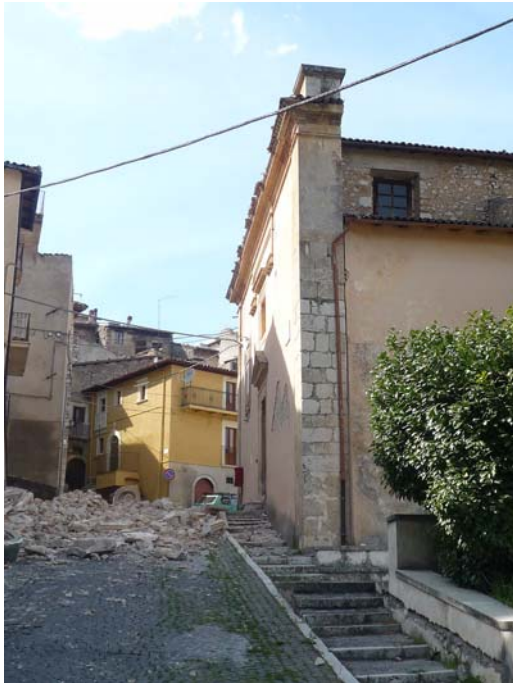
Bild 6.76: Herausfallen des Giebels und Ablösen der Wand gem. Mechanismen K1 und K2 (FBR_P1000199, FBR_P1000201)
