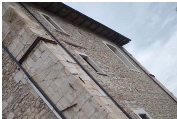
Bild 4.16: Chiesa parrocchiale in Paganica: Verankerungen von Zugstangen und Verstärkung der Ecken (FBR_P1000287)
