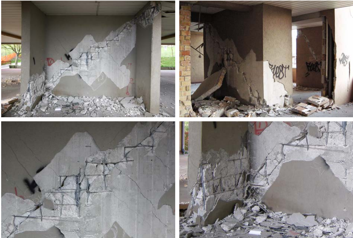
Bild 5.51: MFH 1 mit Stahlbetonwänden: U-förmige Wand am Westende des Gebäudes (AD0183, KB0805, AD0183, KB0764)
