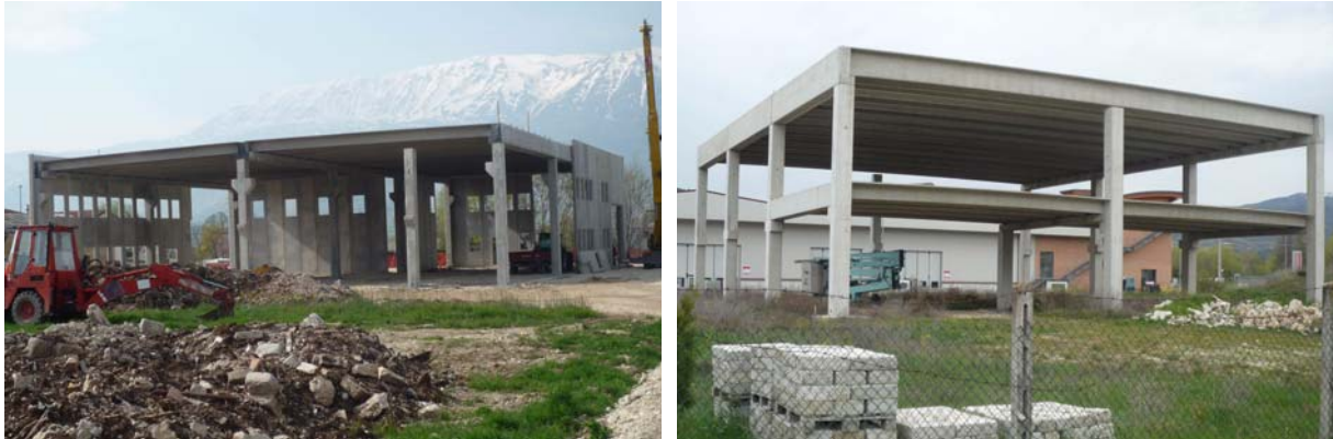
Bild 5.81: Fabrikhallen aus vorfabrizierten Stahlbetonteilen im Rohbau (FBR_P1000060, FBR_P1000296)
