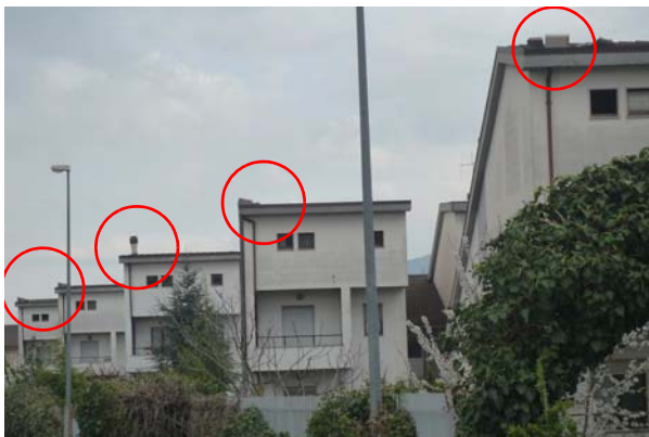
Bild 7.7: Schornsteine einer Wohnsiedlung identischer Reihenhäuser mit mehr oder weniger grosser Beschädigung an der Strada Vicinale dei Cappuccini im östlichen Stadtgebiet von L'Aquila (FBR_P1000133 & FBR1000134)
