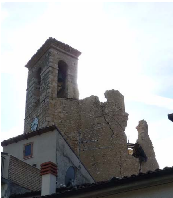
Bild 6.74: Einsturz der Apsis gem. Mechanismen K11 und K12 (FBR_P1000191)
