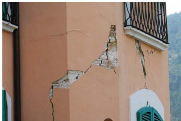
Bild 4.24: Nahaufnahme des Mauerwerks (KB0726)
