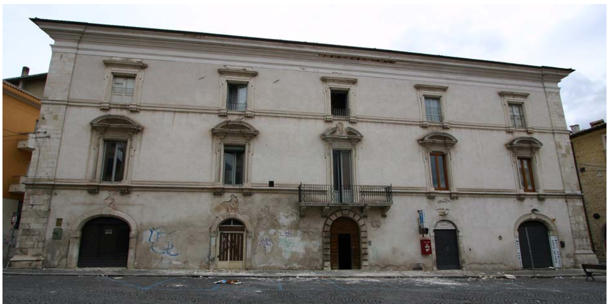
Bild 6.106: Ansicht an den Palazzo ohne sichtbare grössere Schäden (AD0478)
