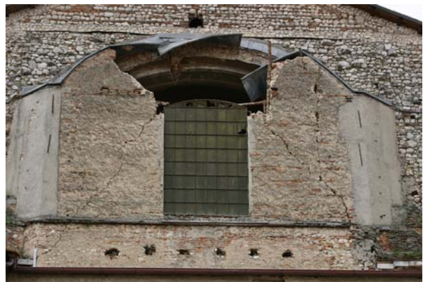
Bild 6.42: Leichte Schäden an herausragenden Wandelementen auf dem Dach gem. Mechanismus K18 (AD0454)
