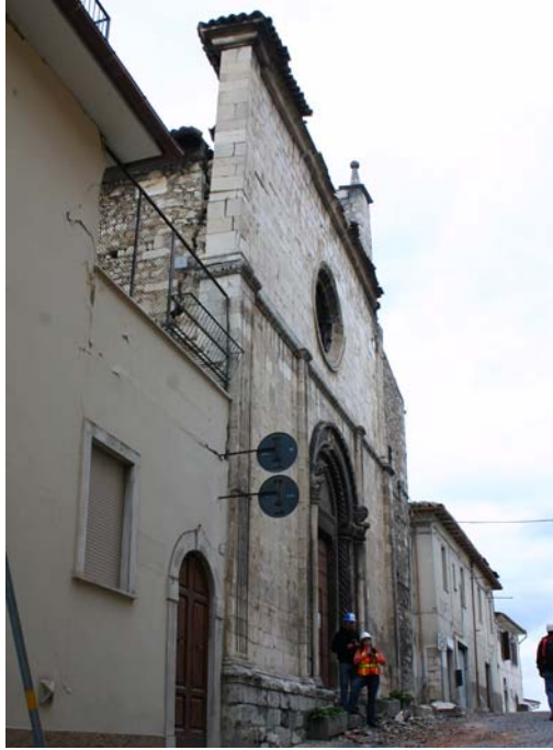
Bild 6.70: Sichtbares Ablösen der Hauptfassade und starke Risse innerhalb der Fassadenfläche gem. Mechanismen K1 und K3 (AD0479, AD0480)
