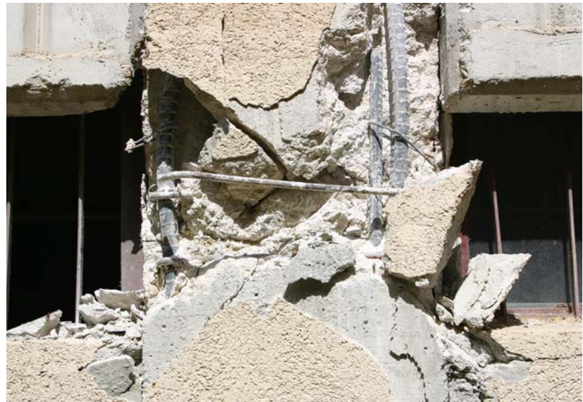
Bild 5.39: Gemischte Tragwerksstruktur: Kurze Stützen im Erdgeschoss (AD0261, AD0250)
