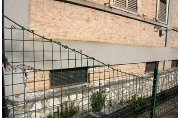
Bild 5.8: Dreigeschossiges Stahlbetonrahmengebäude: Nahaufnahme der kurzen Stützen und des Riegels oberhalb des Fundaments (AD0323)
