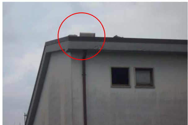
Bild 7.7: Schornsteine einer Wohnsiedlung identischer Reihenhäuser mit mehr oder weniger grosser Beschädigung an der Strada Vicinale dei Cappuccini im östlichen Stadtgebiet von L'Aquila (FBR_P1000133 & FBR1000134)
