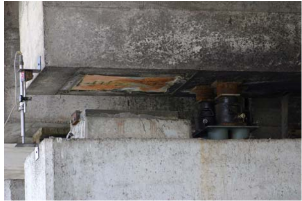
Bild 5.78: Viadotto San Sisto: Vorrichtung zum Austauschen der Lager (AD0303)
