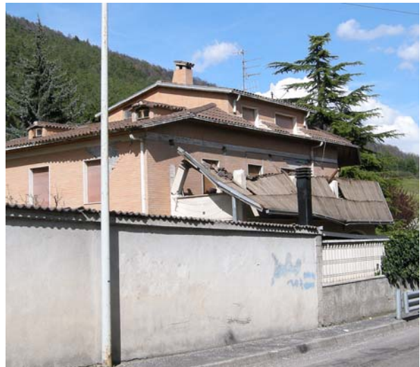
Bild 7.14: Eingestürztes Dach über der Terrasse eines Wohnhauses im Stadtgebiet von L'Aquila nahe dem Viadotto San Sisto (KB0843)
