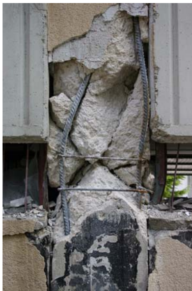
Bild 5.39: Gemischte Tragwerksstruktur: Kurze Stützen im Erdgeschoss (AD0261, AD0250)
