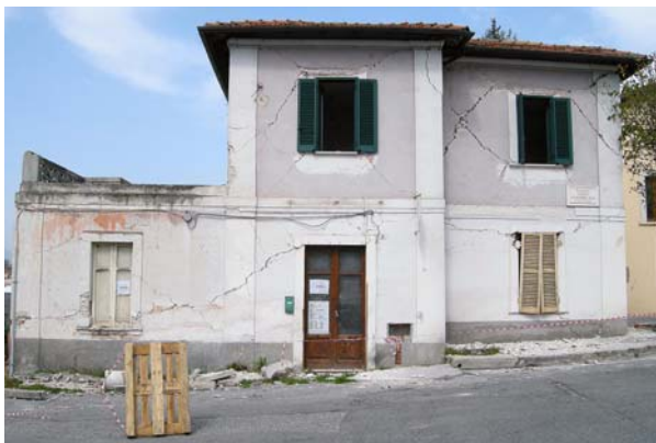
Bild 4.1: Gebäude aus Bruchsteinmauerwerk am Bahnhofplatz in L'Aquila (KB0739)
