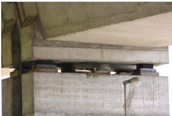
Bild 5.79: Viadotto San Sisto: Neue, temporäre Neoprenlager (AD0292)
