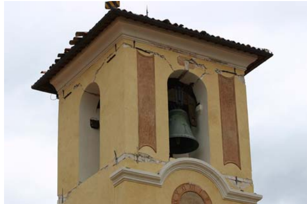
Bild 6.71: Ansicht auf die zweite Kirche und das benachbarte Kloster mit Schäden am Glockenturm gem. Mechanismus K16 (AD0484, AD0483)
