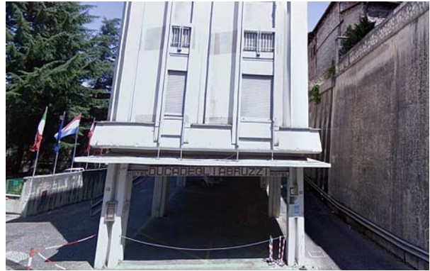
Bild 5.11: Hotel Duca degli Abruzzi: Stahlbetonrahmengebäude mit Mauerwerksausfachungen und sehr weichem Erdgeschoss vor dem Erdbeben (SV0002, SV0003 [SV09])
