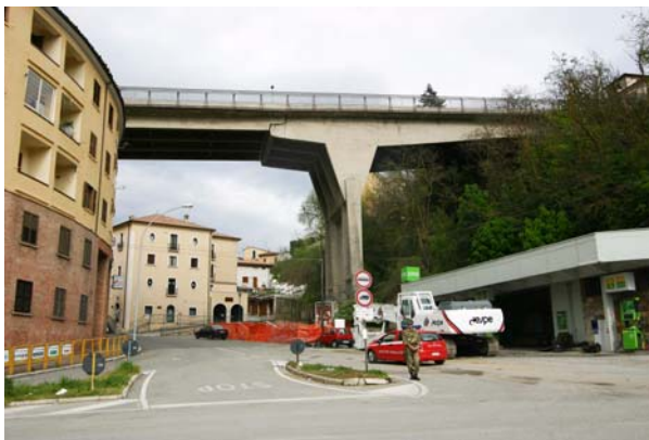
Bild 5.61: Stadtbrücke: Dreifeldträger aus Stahlbeton (AD0516)
