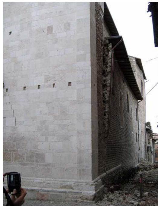
Bild 6.64: Auskippen der Seitenwand gem. Mechanismus K10 (AD0930)
