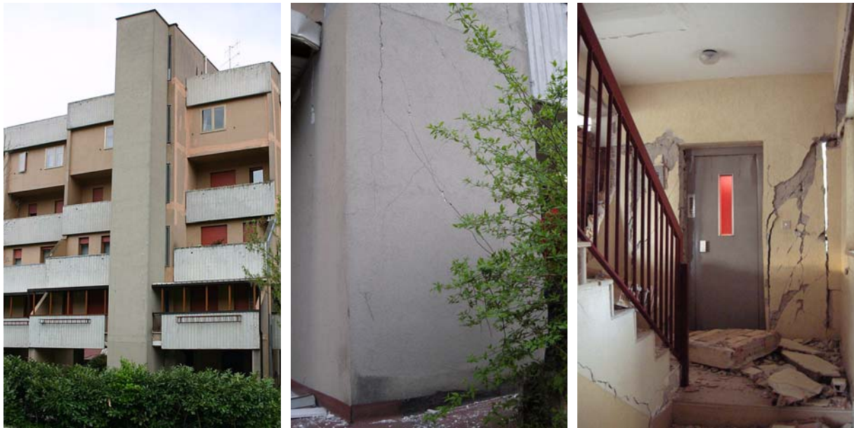
Bild 5.53: MFH 1 mit Stahlbetonwänden: Liftschacht am Westende des Gebäudes (AD0191, KB0809, KB0807)
