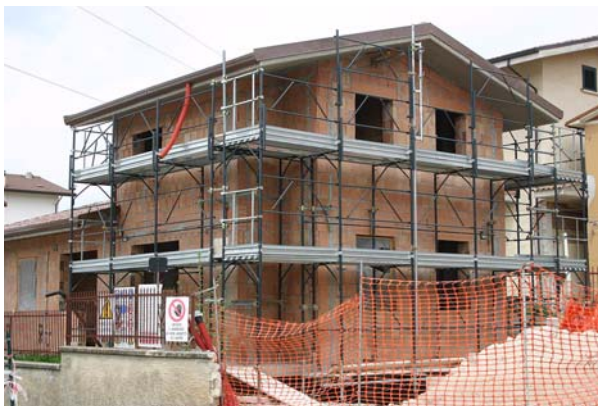
Bild 4.29: Wohngebäude in L'Aquila aus Betonsteinmauerwerk (AD0145)
