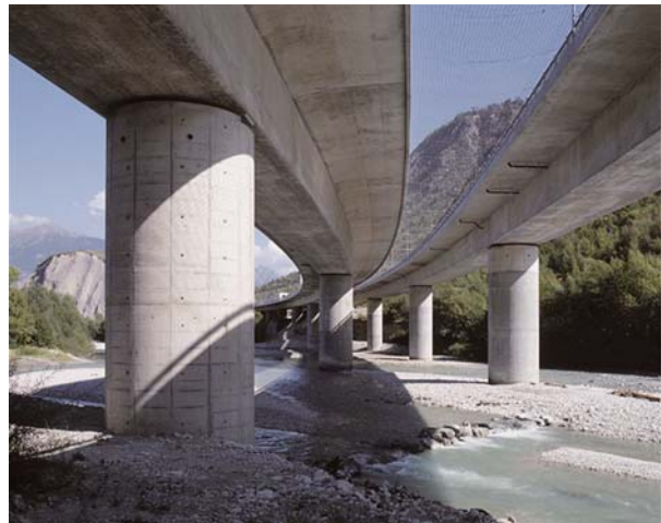
Bild 3.20: Viadukt Iles Falcon in Sierre als vorgespannter Durchlaufträger im Taktchiebeverfahren hergestellt (XMI)
