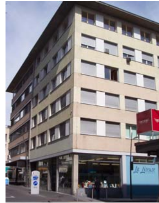
Bild 3.28: Wohnbau im Stadtzentrum von Sion mit soft-storey Gefährdung (XMI)
