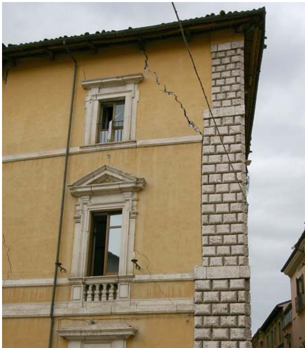
Bild 6.107: Schwere sichtbare Schäden an der Fassadenwand gem. Mechanismus P17 (AD0460, AD0461) und Schäden am Gebäude durch Einsturz des Nachbargebäudes (AD0467)
