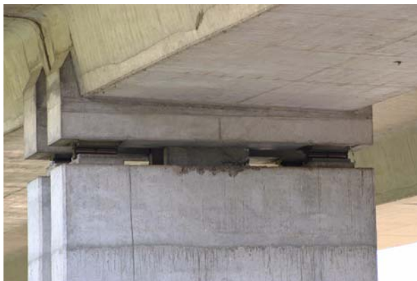
Bild 5.71: Viadotto San Sisto: Stützenkopf (AD0291)
