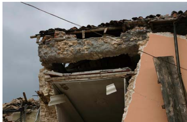
Bild 4.20: Nahaufnahme des Ringbalkens des Gebäudes im Bild 4.19 (AD0559)
