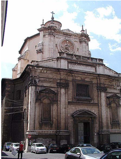
Bild 6.66: Ansicht an die Kirche vor dem Erdbeben ( http://images.google.ch )
