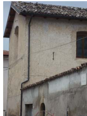
Bild 6.83: Weitere Kirche in Monticchio ohne sichtbare Schäden am Kirchbau oder Turm; An den Pfeilern des Turmes sind Sicherungsmassnahmen in Form von Stahlbändern, an der Seitenwand der Kopfe eines Ankers zu erkennen (FBR_P1000308, FBR_P1000309, FBR_P1000318, FBR_P1000319)
