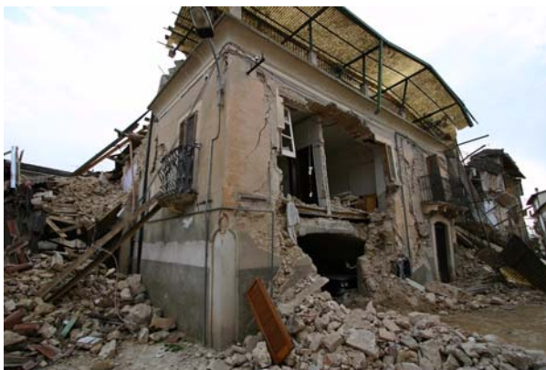
Bild 4.11: Gebäude in Onna aus Bruchsteinmauerwerk mit Holzbalkendecke und Zugelementen aus Stahl (AD0029)
