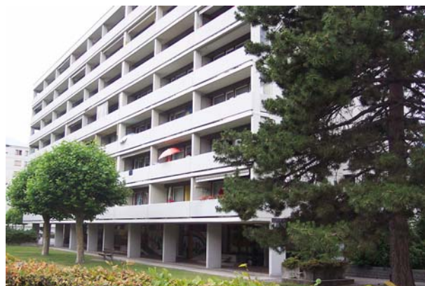
Bild 3.26: Wohnbau in Sion mit offenem Erdgeschoss als Stahlbetonrahmen ausgebildet (XMI)
