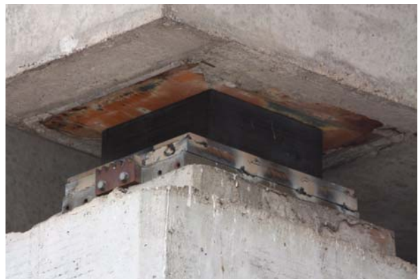
Bild 5.80: Viadotto San Sisto: Nahaufnahme eines neuen Neoprenlagers (XMI_2627)
