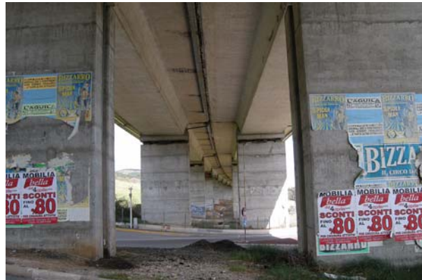
Bild 5.70: Viadotto San Sisto: Unter der Brücke (KB0846)
