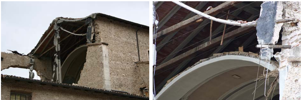
Bild 6.51: Sichtbarer neuer Dachaufbau und darunter liegendes altes Dachgewölbe (AD0410, AD0416)
