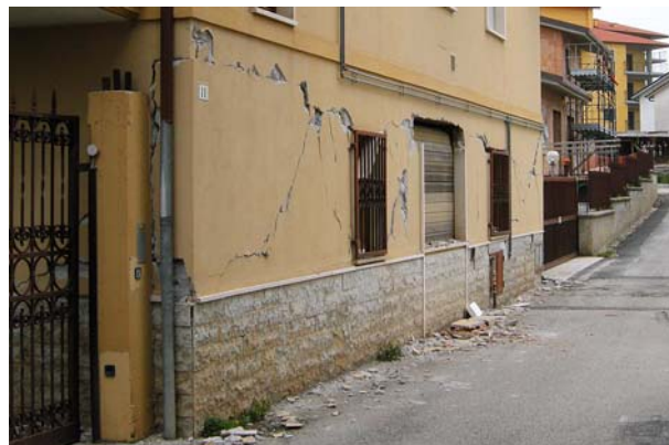
Bild 4.28: Wohngebäude in L'Aquila aus Betonsteinmauerwerk (KB0756)
