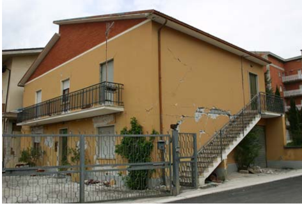
Bild 4.29: Wohngebäude in L'Aquila aus Betonsteinmauerwerk (AD0145)
