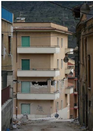
Bild 5.35: Stahlbetonrahmengebäude im Stadtzentrum (AD0560)
