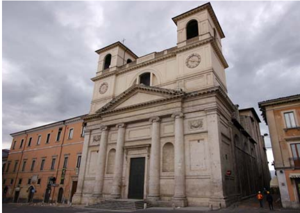
Bild 6.47: Keine sichtbaren Schäden an der Hauptfassade des Duomo (AD0572)
