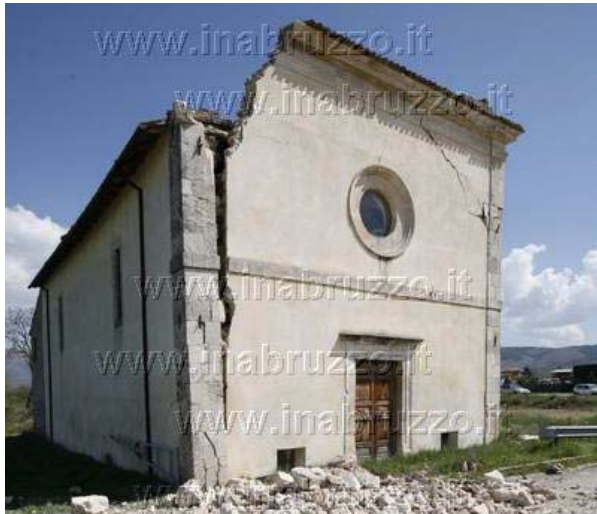
Bild 6.79: Kirche entlang der Strasse SR5bis nach L'Aquila: Ablösen der Fassadenwand und Teileinsturz des Daches gem. Mechanismen K1 und K3 ( http://www.inabruzzo.it )
