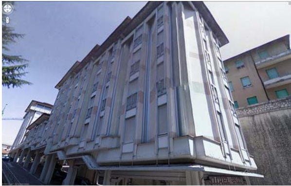
Bild 5.11: Hotel Duca degli Abruzzi: Stahlbetonrahmengebäude mit Mauerwerksausfachungen und sehr weichem Erdgeschoss vor dem Erdbeben (SV0002, SV0003 [SV09])
