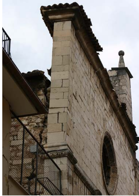
Bild 6.70: Sichtbares Ablösen der Hauptfassade und starke Risse innerhalb der Fassadenfläche gem. Mechanismen K1 und K3 (AD0479, AD0480)
