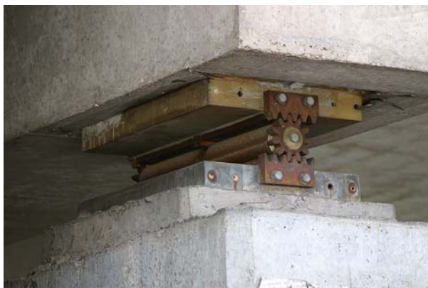
Bild 5.73: Viadotto San Sisto: Rollenlager (AD0294)
