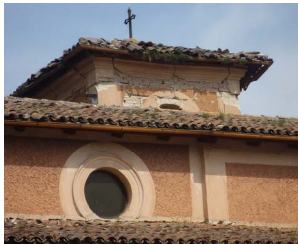
Bild 6.81: Herausfallen der Giebelwand der Chiesa gem. Mechanismus K2 und beginnendes Ablösen der Fassadenwand gem. Mechanismus K1. Leichte Schäden am Dachaufbau gem. Mechanismus K18 (XMI_2467_1, FBR_P1000082, FBR_P1000078, FBR_P1000076)
