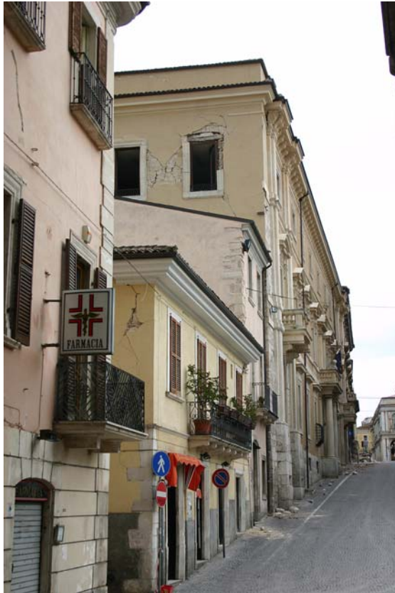
Bild 6.105: Palast 2: Bedeutende Schäden an den Aussenwänden aus Bruchsteinmauerwerk gem. Mechanismen P5 und P6 (AD0464, AD0453)
