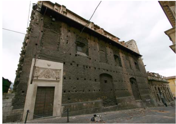
Bild 6.42: Leichte Schäden an herausragenden Wandelementen auf dem Dach gem. Mechanismus K18 (AD0454)
