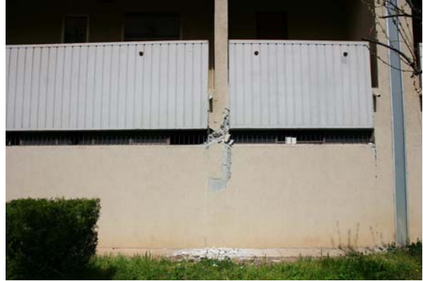
Bild 5.38: Gemischte Tragwerksstruktur: Kurze Stütze im Erdgeschoss (AD0253)
