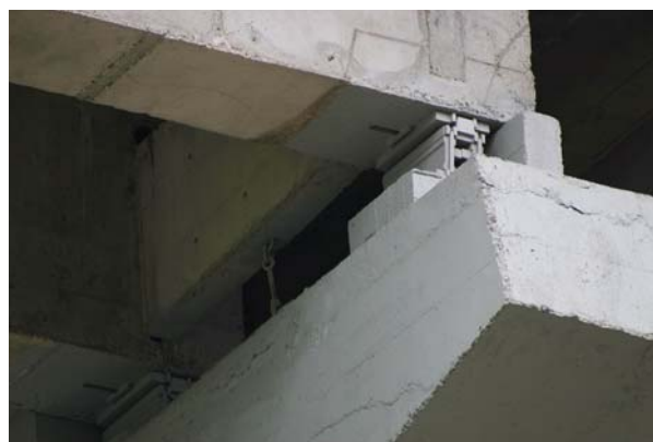
Bild 5.68: Autobahnbrücke nahe des Epizentrums: Nahaufnahme des Gleitlagers (AD0164)
