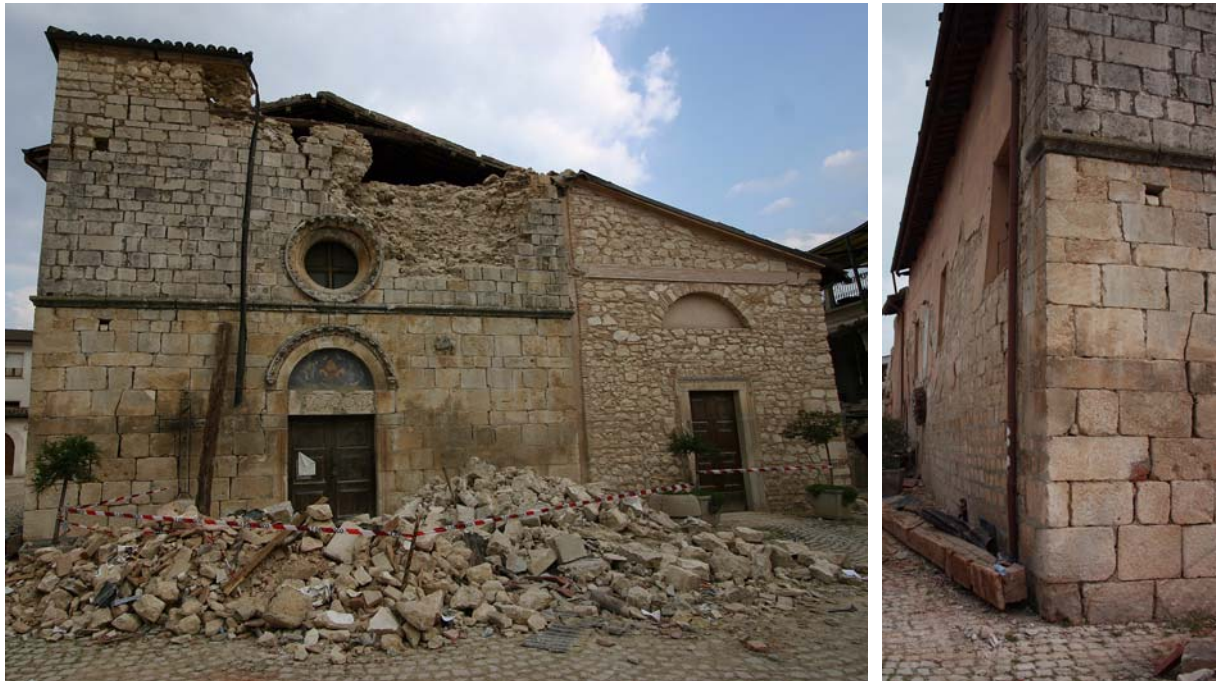
Bild 6.84: Herausfallen der Giebelwand der Fassade; Sichtbare horizontale Verschiebung der mittleren Steinlagen der Seitenwand gem. Mechanismen K2 und K13 (AD0028, XMI_2429)
