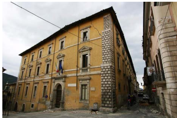
Bild 4.2: Palast aus Bruchsteinmauerwerk mit Eckpfeilern aus behauenen Steinen im Stadtzentrum von L'Aquila (AD0460)
