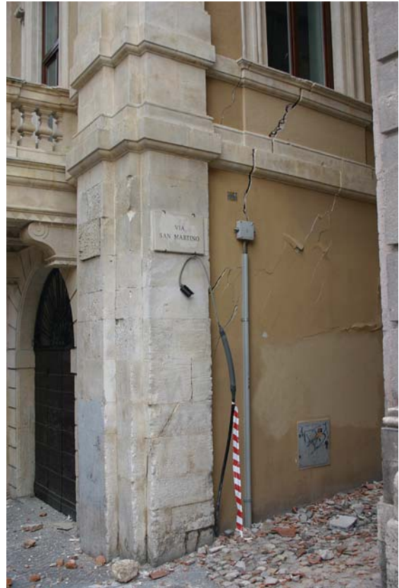
Bild 6.105: Palast 2: Bedeutende Schäden an den Aussenwänden aus Bruchsteinmauerwerk gem. Mechanismen P5 und P6 (AD0464, AD0453)
