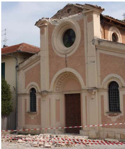
Bild 6.79: Kirche entlang der Strasse SR5bis nach L'Aquila: Ablösen der Fassadenwand und Teileinsturz des Daches gem. Mechanismen K1 und K3 ( http://www.inabruzzo.it )
