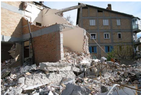
Bild 5.3: Zweigeschossiges Stahlbetonrahmengebäude: Übergang zwischen versagtem und nicht versagtem Gebäudeteilen (KB0856)
