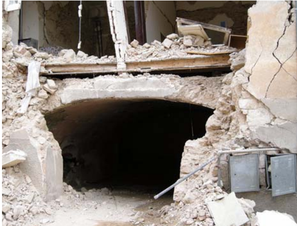
Bild 4.17: Gebäude im Bild 4.11: Gewölbestruktur im EG und Zugelement vor der Holzbalckendecke zwischen EG und 1. OG (KB0686)
