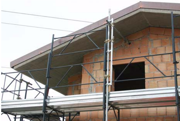
Bild 4.31: Sich noch im Bau befindendes modernes Mauerwerksgebäude mit Stahlbetonelementen in L'Aquila (AD0150, AD0140, AD0141, AD0143)
