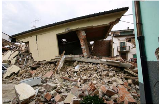
Bild 4.22: Wohnhaus mit einem Erdgeschoss aus Bruchsteinmauerwerk und einem Obergeschoss aus modernem Ziegelsteinmauerwerk mit Stahlbetondecke und Dach aus dem SLC-Deckensystem (AD0020)
