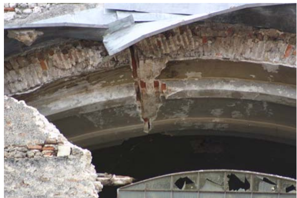
Bild 6.43: Detailansichten der Schäden an der Kirche nach dem Erdbeben: Auskippen eines Fassadenteils gem. Mechanismus K3 im Bereich einer (nachträglich verschlossenen) Öffnung, lokaler Querschnittsaufbruch im Bogenmauerwerk erkennbar (AD0456, AD0457, AD0458, AD0459)
