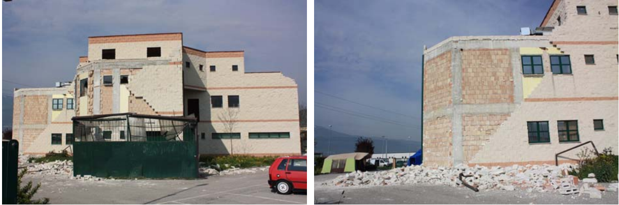
Bild 5.43: Neues Stahlbetonrahmengebäude mit unbeschädigter Tragstruktur (XMI_2449, XMI_2451)
