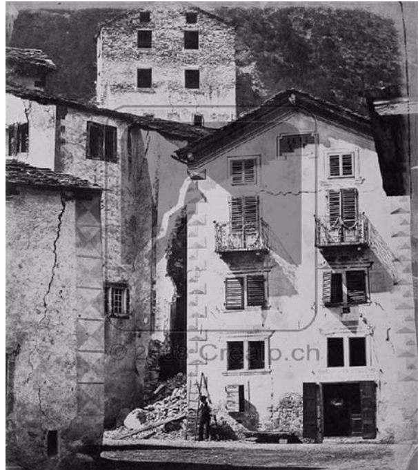
Bild 3.6: Schäden an einem Gebäude von Visp aus Bruchsteinmauerwerk mit Eckpfeilern aus behauenen Natursteinblöcken infolge des Erdbebens von 1855 (CREALP)
