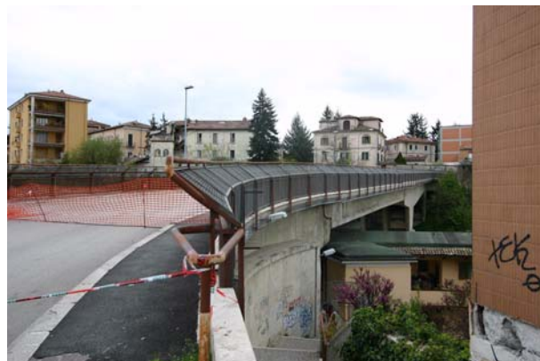
Bild 5.62: Stadtbrücke: Auf Fahrbahnniveau (AD0493)
