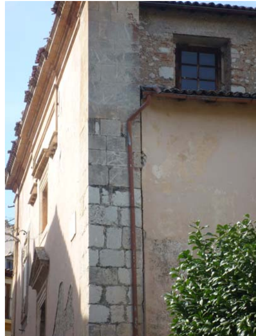
Bild 6.76: Herausfallen des Giebels und Ablösen der Wand gem. Mechanismen K1 und K2 (FBR_P1000199, FBR_P1000201)
