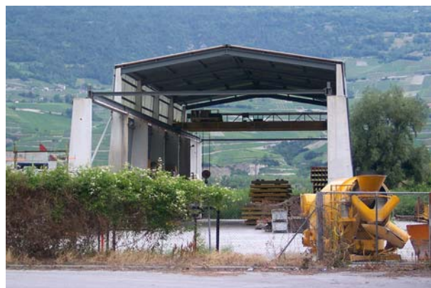
Bild 3.22: Industriehalle in Chalais, Wallis (XMI)
