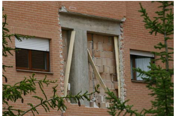
Bild 5.47: Relativ neues Wohngebäude mit zweischalige Mauerwerksausfachung (AD0203, AD0202)
