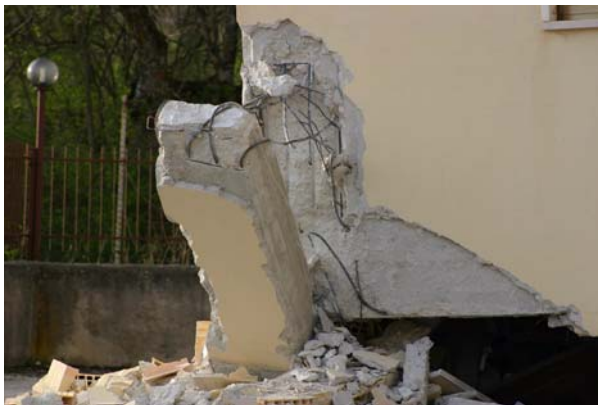
Bild 5.27: MFH 2: Rahmenknoten in Bild 1.22 vorne links (AD0217)
