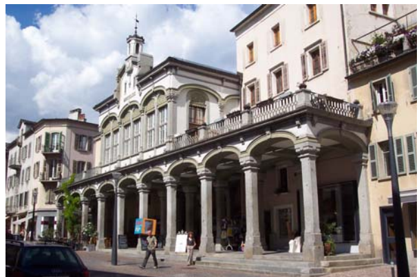
Bild 3.14: Historisches Bauwerk mit Säulen in Sion (XMI)
