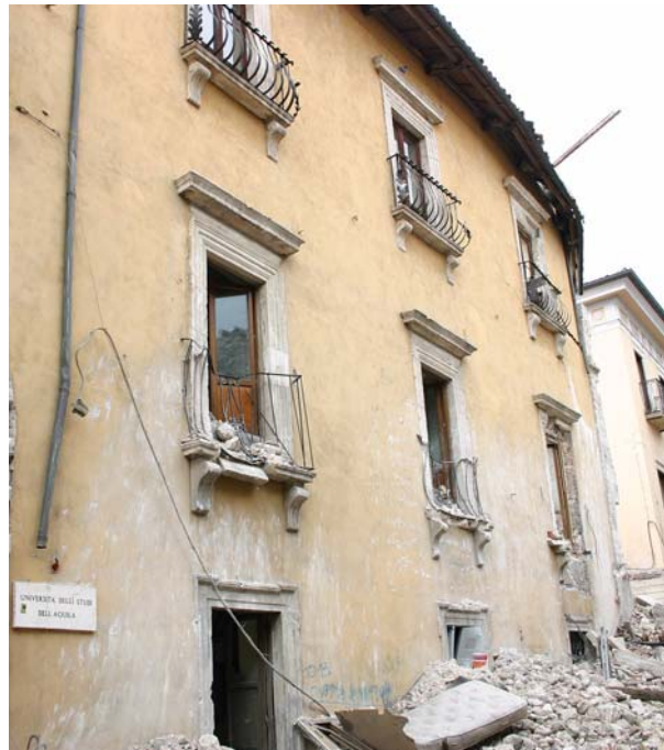
Bild 6.107: Schwere sichtbare Schäden an der Fassadenwand gem. Mechanismus P17 (AD0460, AD0461) und Schäden am Gebäude durch Einsturz des Nachbargebäudes (AD0467)
