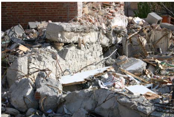
Bild 5.5: Zweigeschossiges Stahlbetonrahmengebäude: Das Fundament scheint grösstenteils aus Bruchsteinmauerwerk zu bestehen (AD0326)
