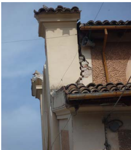
Bild 6.81: Herausfallen der Giebelwand der Chiesa gem. Mechanismus K2 und beginnendes Ablösen der Fassadenwand gem. Mechanismus K1. Leichte Schäden am Dachaufbau gem. Mechanismus K18 (XMI_2467_1, FBR_P1000082, FBR_P1000078, FBR_P1000076)
