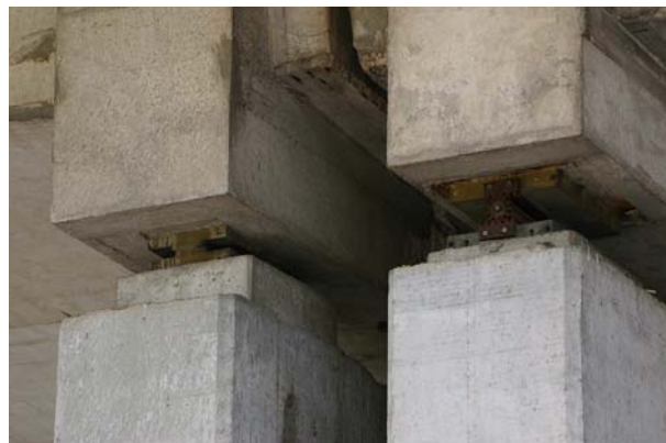
Bild 5.72: Viadotto San Sisto: Kipp- und Rollenlager (AD0285)
