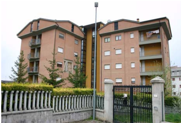
Bild 5.47: Relativ neues Wohngebäude mit zweischalige Mauerwerksausfachung (AD0203, AD0202)
