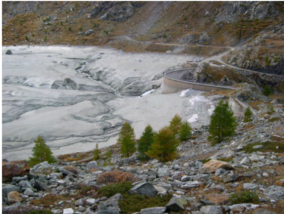
Figure 1 : Vue sur le bassin de retenue de Tourtemagne lors de la réalisation d'une purge annuelle (2004/Marc Wyer).
