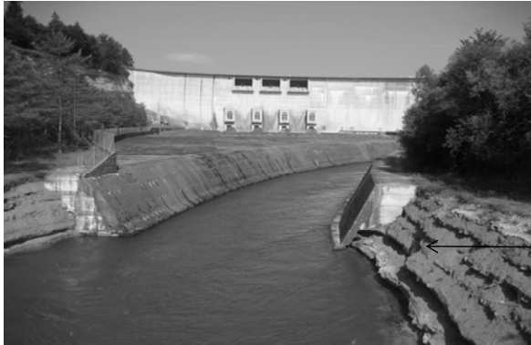
Figure 2. Fin de la partie bétonnée du canal de fuite (proximité de la passerelle aval) : Développement de l'érosion en strates sur la molasse qui n'est plus protégée par le béton.
