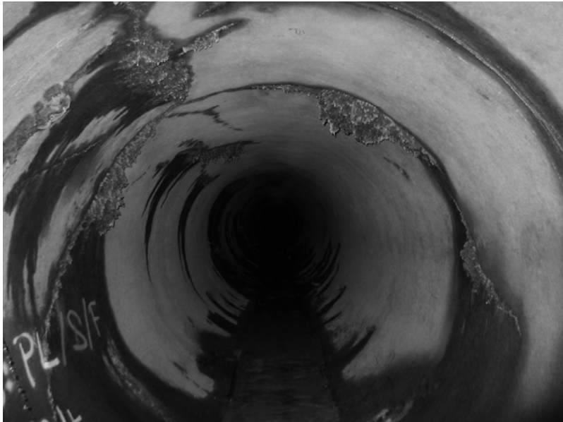
Abbildung 2: Stollen bei Laufmeter 474 mit Sinterungen (Quelle: ewz)
