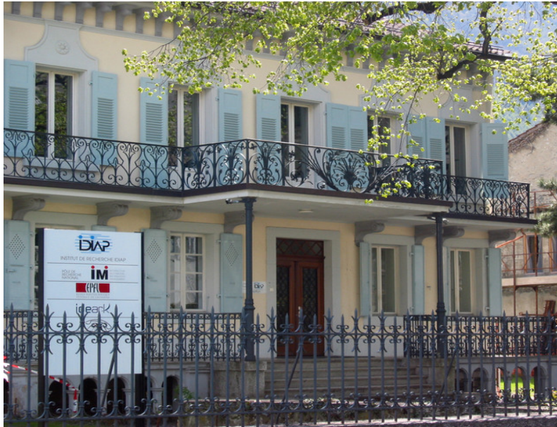
FIG. 1.1 – Villa Tissières, local principal de l'IDIAP
