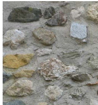
Figure 4.11: Exemple de maçonnerie cyclopéenne
