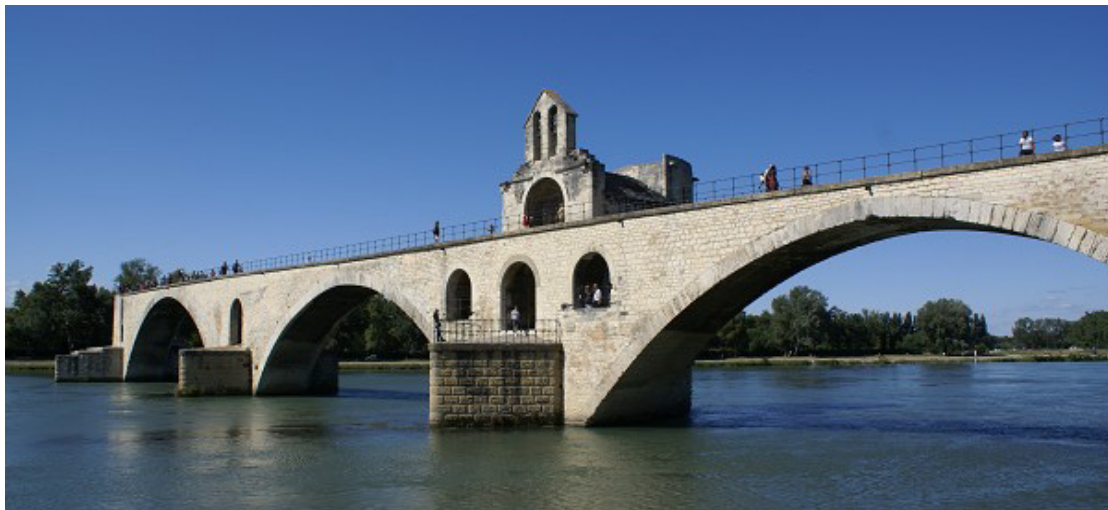
Figure 2.10 : Pont St-Bénézet, à Avignon (Photo : Nicolas Janberg, www.structurae.de ) [2.3]
