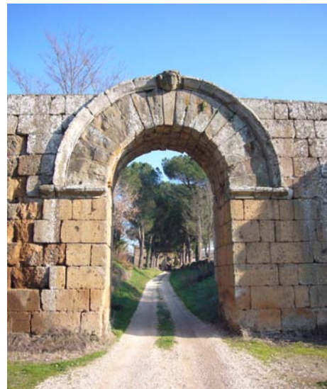
Figure 2.8 : Arc étrusque, à Falerii Novi [2.4]
