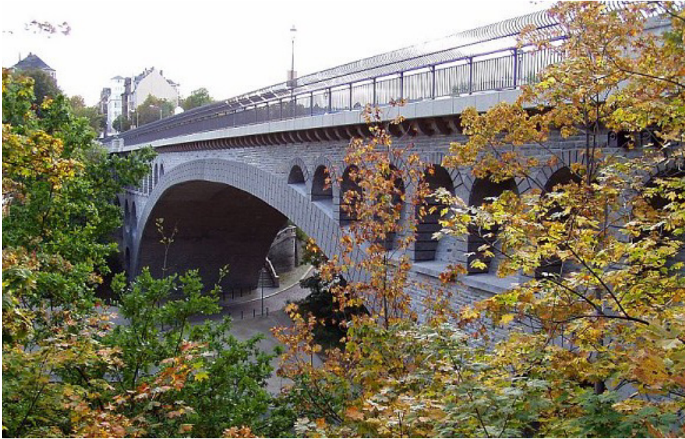
Figure 2.6 : Pont Frédéric Auguste, à Plausen (Photo : Thomas Joram, www.structurae.de ) [2.3]
