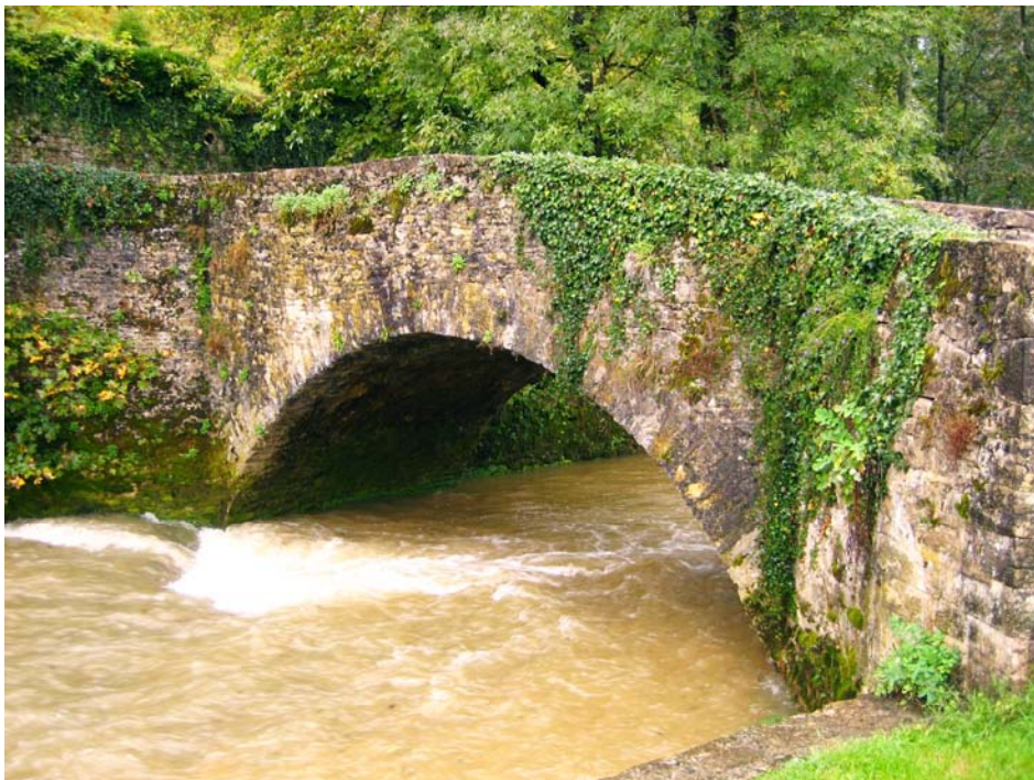
Figure 1.1 : Pont de Baume les Messieurs
