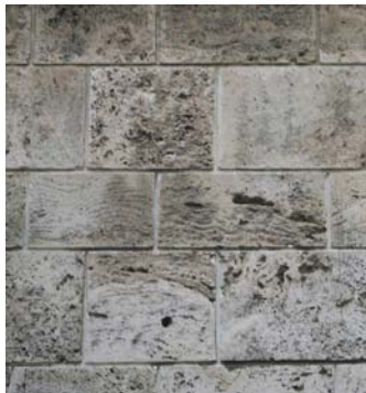
Figure 4.10 : Exemple de maçonnerie de pierre de taille
