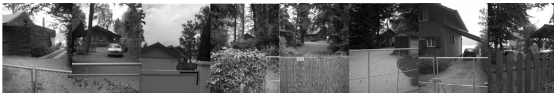
Oben rechts: ein Neubau in der Wohnzone im Osten von Vinelz
