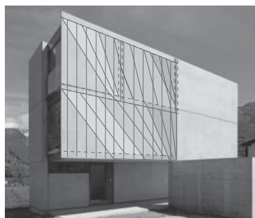
Figure 1.2: Maison Grossi, Monte Carasso 2003, architectes Giacomo&Riccarda Guidotti, ingénieur Marco Kueng.
