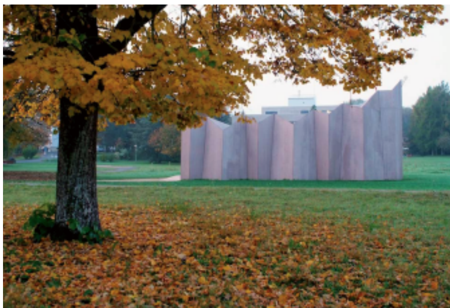
Die Fassade wölbt sich gegen Westen zum «Kirchenturm» auf.
