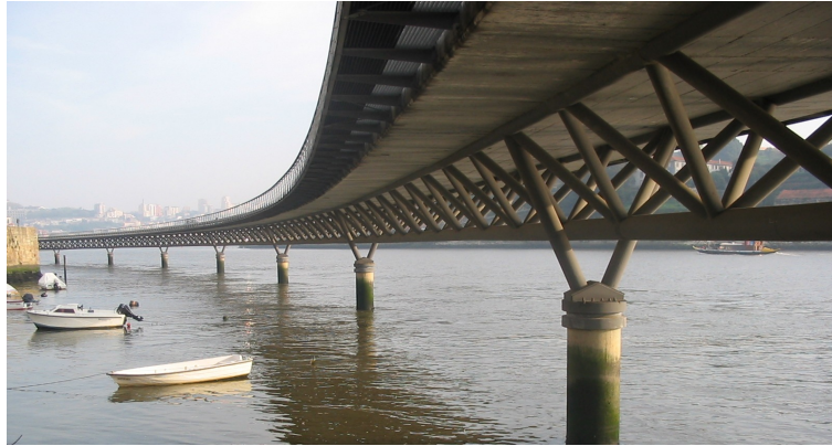
Figure 1.1: Cais das Pedras viaduct (1997, Porto - Portugal).
