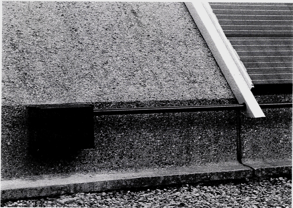
Fig. 4 : Raccordement des câbles au boîtier de connection.
