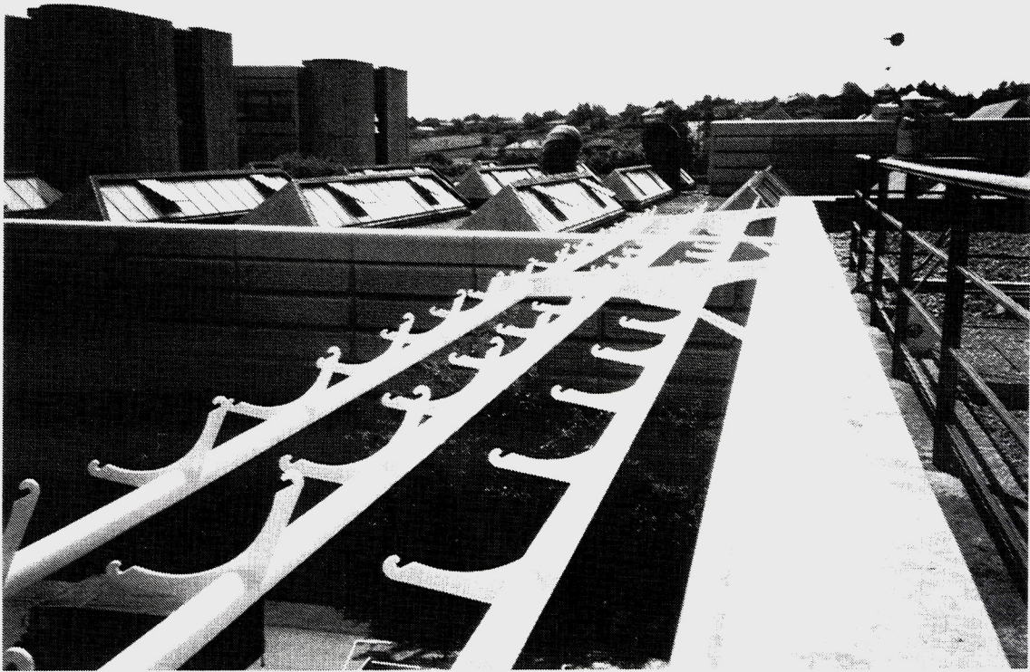
Fig. 10: Support de panneaux avec les éléments "boomerang" et leurs crochets.
