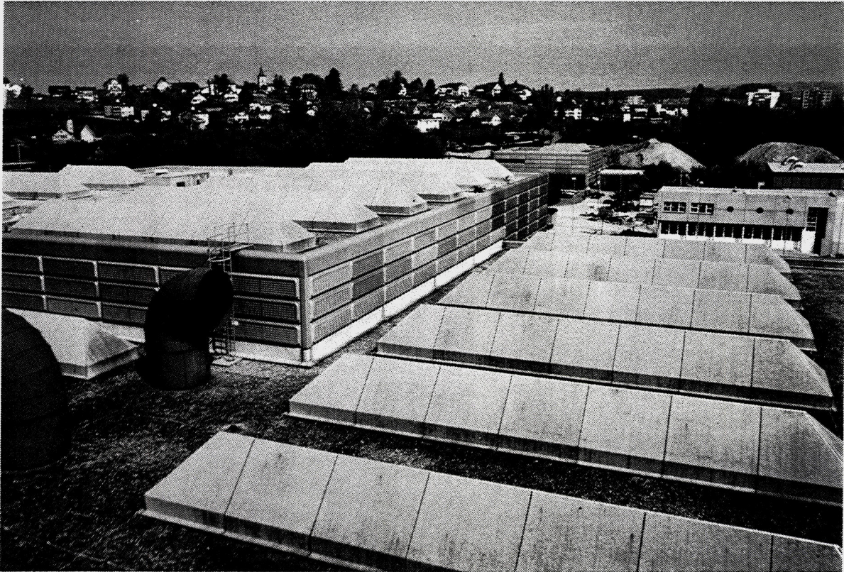
Fig. 1 : Vue générale des sheds de la halle du Génie Civil de l'EPFL avant la réalisation de l'installation photovoltaïque.
