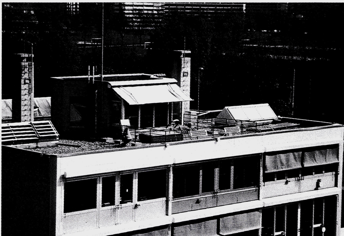
Fig. 9 : Partie supérieure de la façade sud du LESO, on y relève l'absence totale d'avant-toit.
