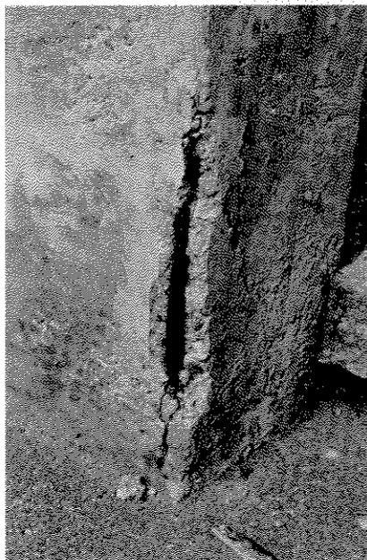
Fig. 8. Dégradation d'un pilier en béton par corrosion des armatures.
