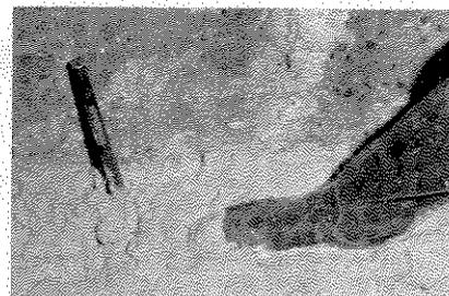
Fig. 3. Détail de l'attaque de la chape en mortier.
