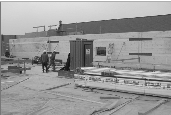
Abb. 17: Montage der Holztrennwände
