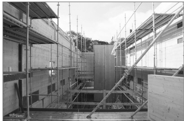
Abb. 18: Montage der Holztrennwände
