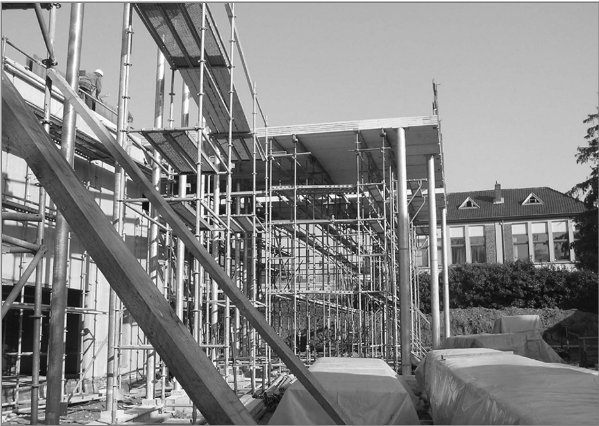
Abb. 16: Montage des Bodens
