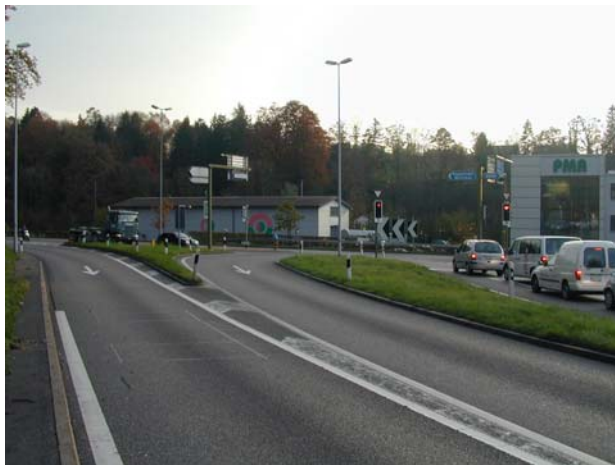
Photo 9: Entrée et sortie d'autoroute
