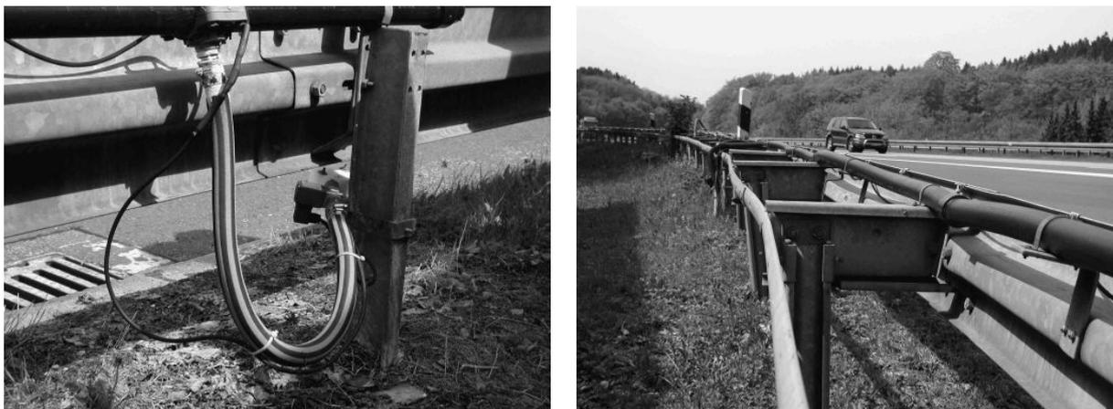
**Figure 12 : Tête de giclage (à gauche) et apport de saumure (à droite) de l'IAD de Lüdenscheid
