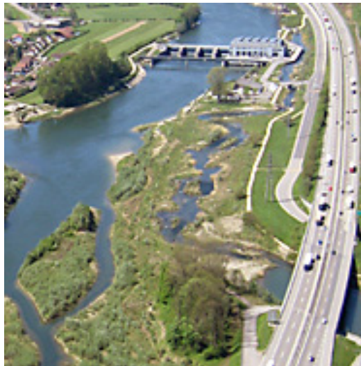
Figure 2. Rivière à poissons à Ruppoldingen
