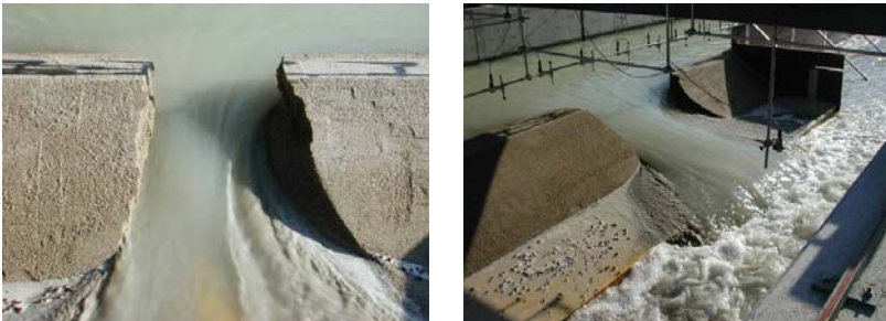
Figure 8: 1) Ouverture de la brèche 2) Allongement de l'ouverture
