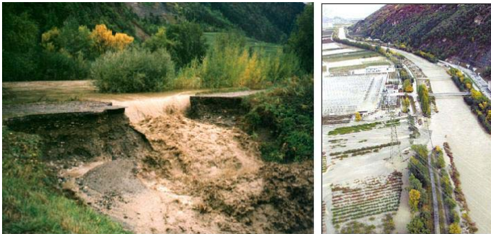
Figure 1 : Ouverture accidentelle de brèches dans les digues latérales du Rhône lors de la crue d'octobre 2000
