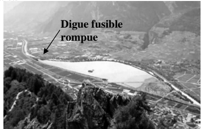
Déversements limités au bassin de rétention aménagé (ici en situation de vidange par la digue fusible rompue).
