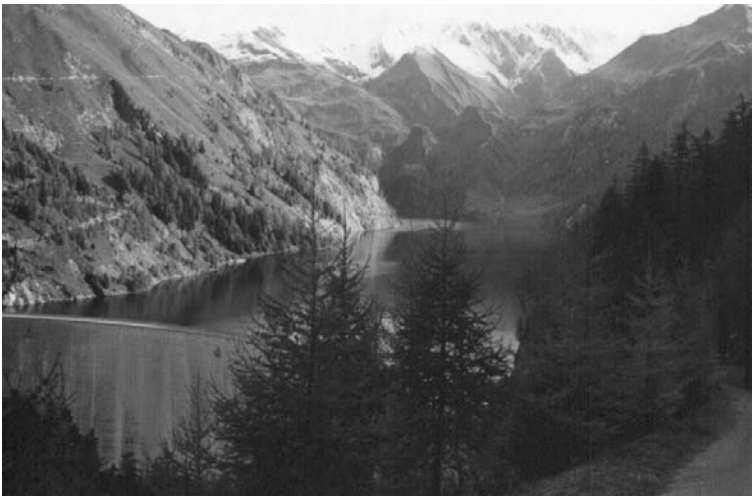
Figure 1.4 : Photo du barrage et de la retenue de Luzzone
