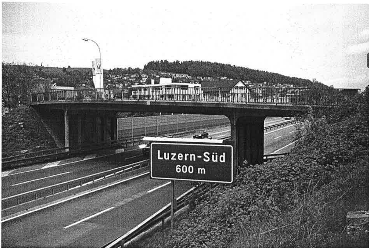
Bild 12 - Überführung Horwerstrasse, Blickrichtung Nord
